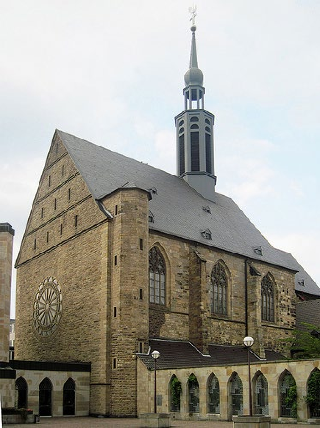
Propsteikirche, ehem. Dominikaer-Kloster Dortmund
