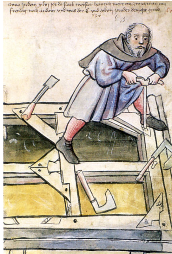
Der Zimmermann (zymerman) bohrt mit einem Löffelbohrer ein Loch für einen Holznagel in das Band einer vorgerichteten Fachwerkwand, auf der zwei Beschlagbeile (Breitbeile) liegen. (fol. 67r)
