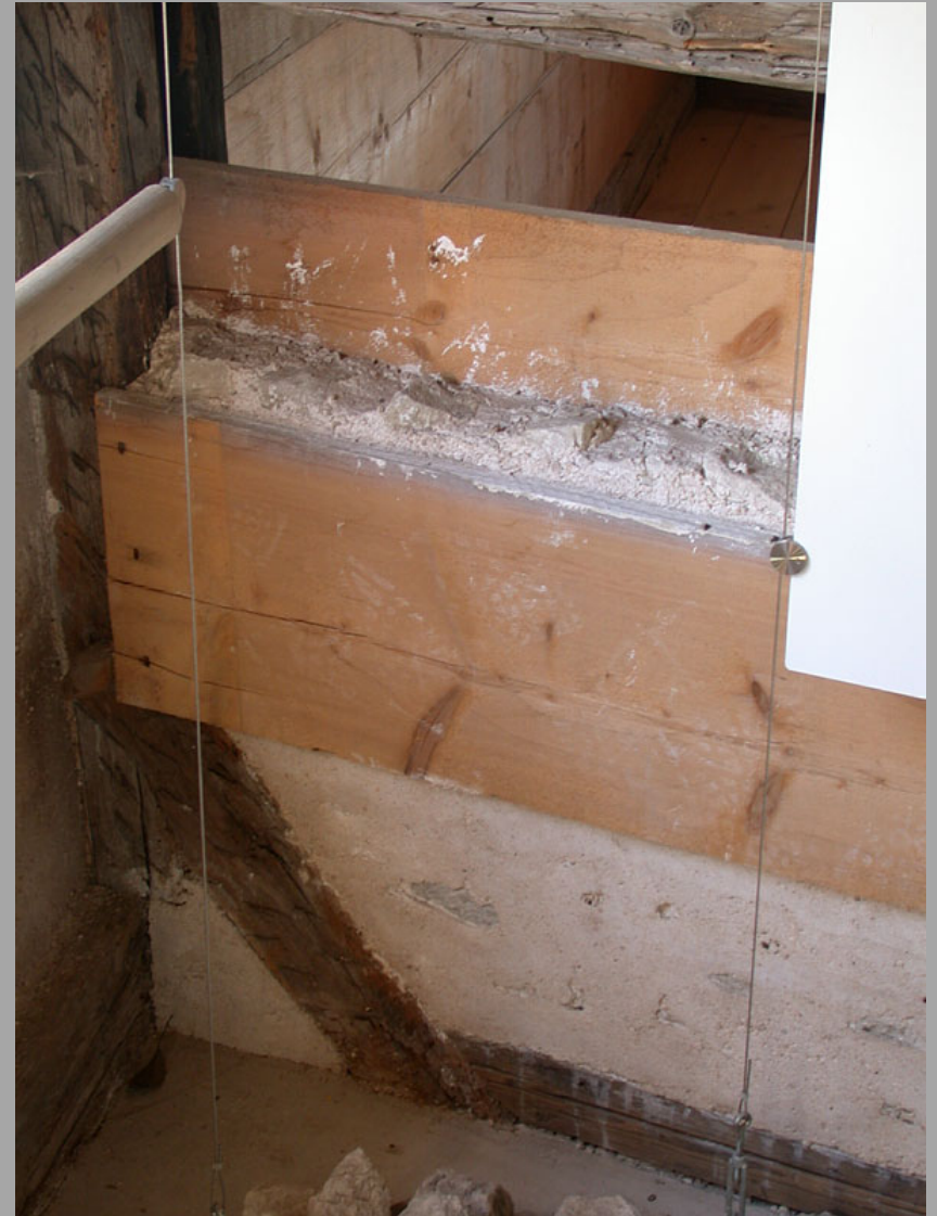
Freilandmuseum Bad Windsheim / „Alter Bauhof“ / historischer Befund einer Ausfachung mit Gipsmörtel und Bruchsteinen / neuzeitliche Nachstellung
