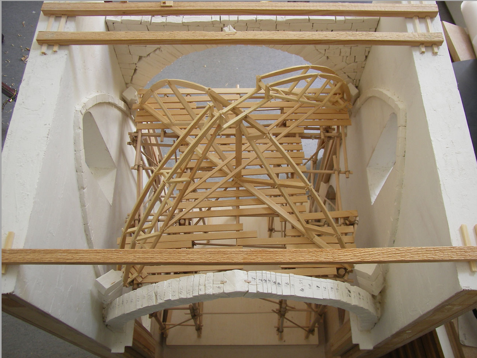
Arbeitsplattform mit Lehrgerüst für die Kreuzrippen
