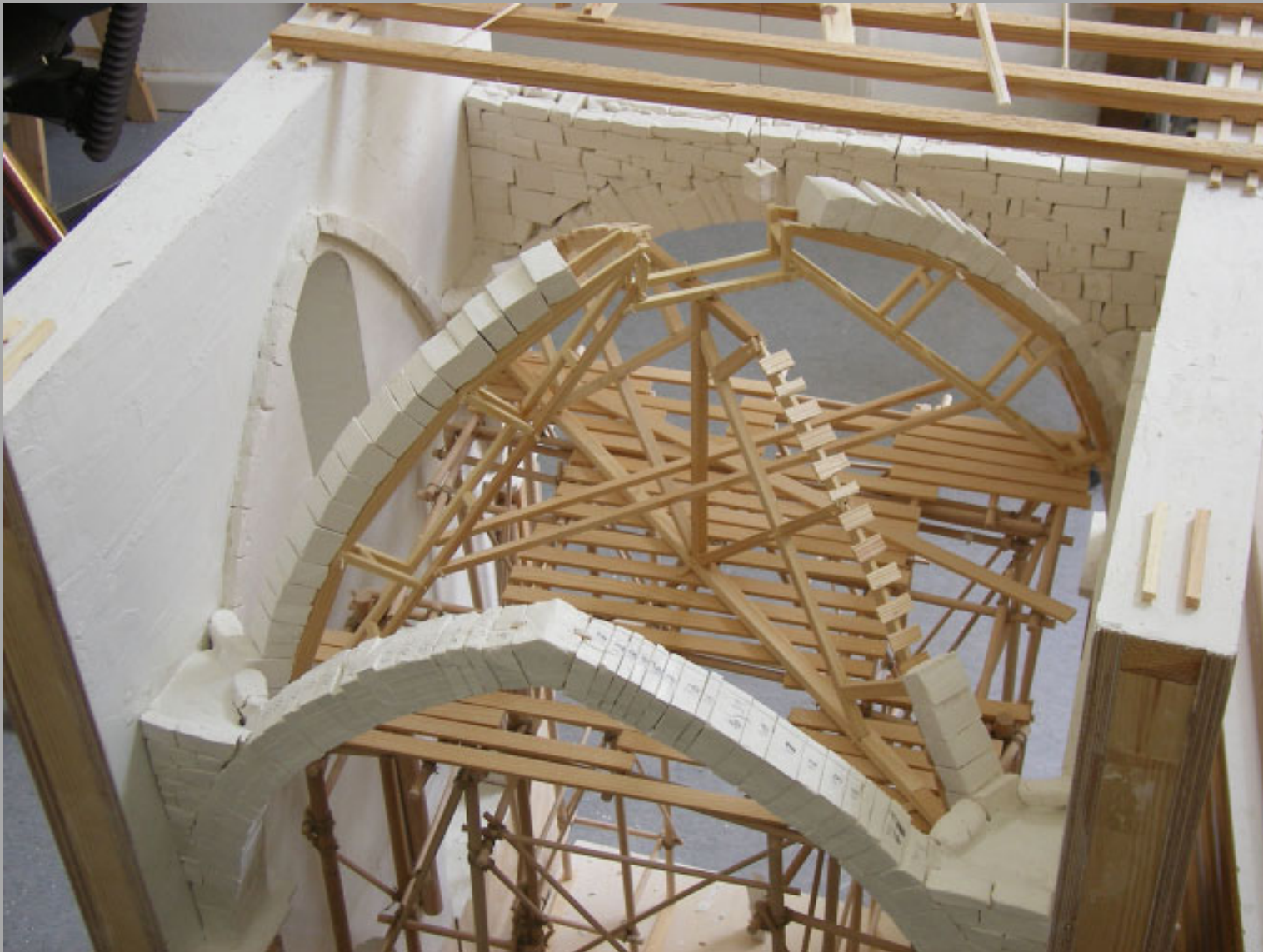
Aufmauerung der Rippen
