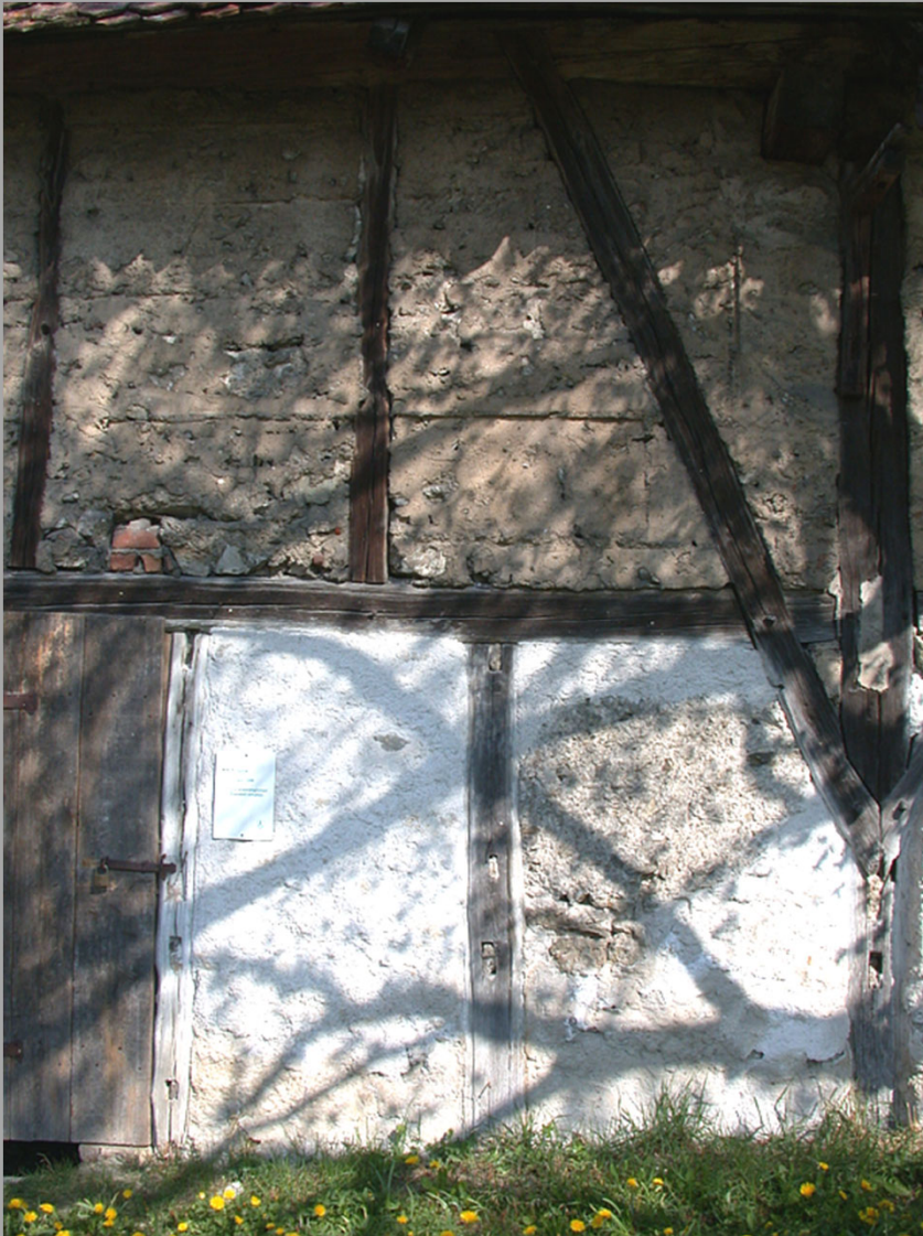
Freilandmuseum Bad Windsheim / „Alter Bauhof“ / historischer Befund einer Ausfachung mit Gipsmörtel und Bruchsteinen / neuzeitliche Nachstellung
