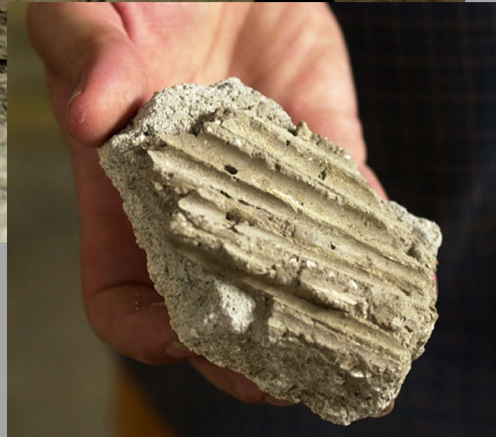
Pompeji / Lehmputz auf Schilfrohr und Deckputz
