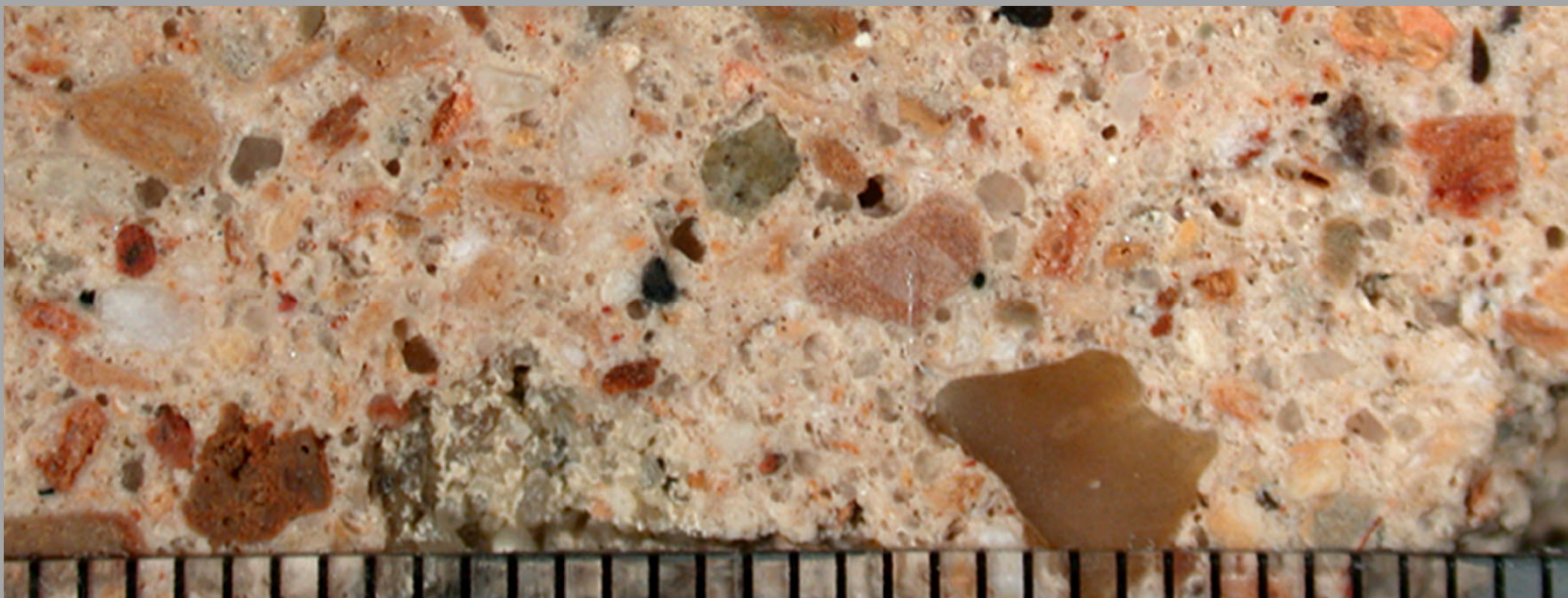
Neues Museum Berlin / Estrich unter Fliesenbelag / Mörtel mit Sand-Zuschlag
