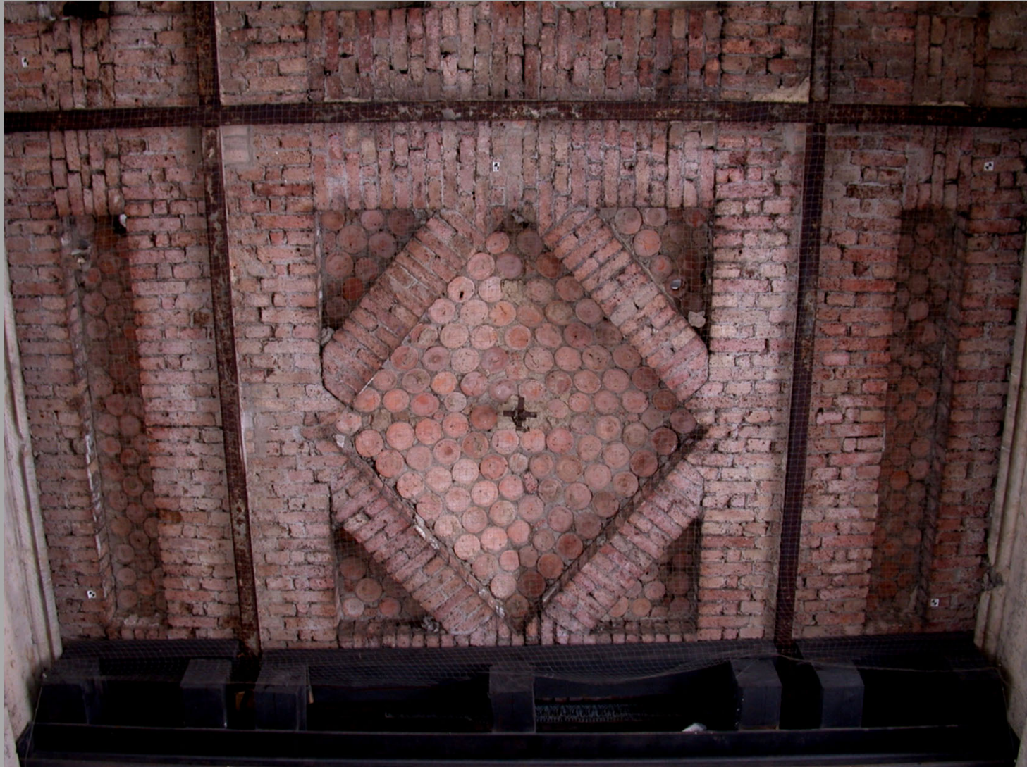
Neues Museum Berlin Tontopfgewölbe mit Hochbrand-Gips-Mörtel vermörtelt
