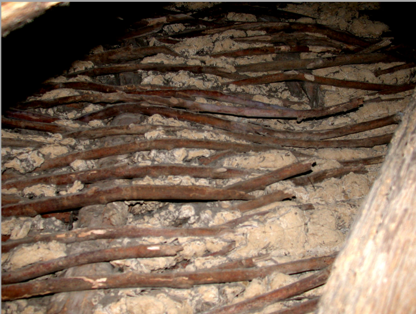
Wasserburg Zilly / Fachwerkgefache mit Weidengeflecht und Lehmverstrich
