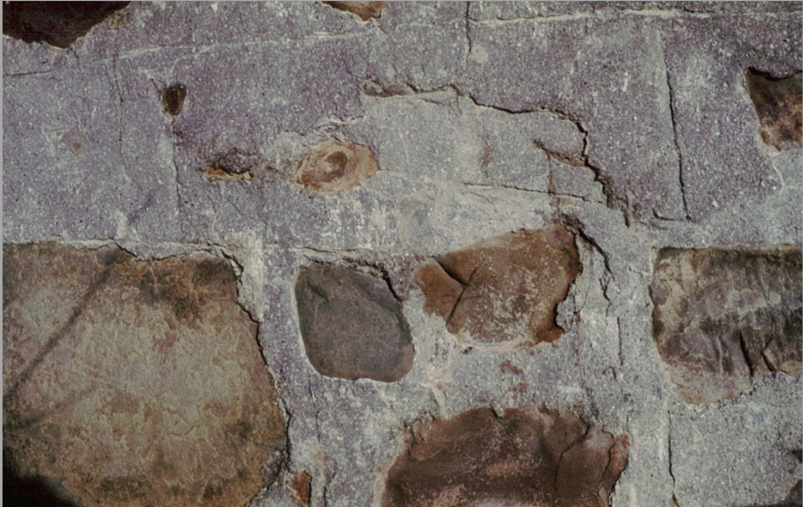
Alte Burg Osterode, Bergfried, Sockelzone, Fugenputz mit Fugenstrich
