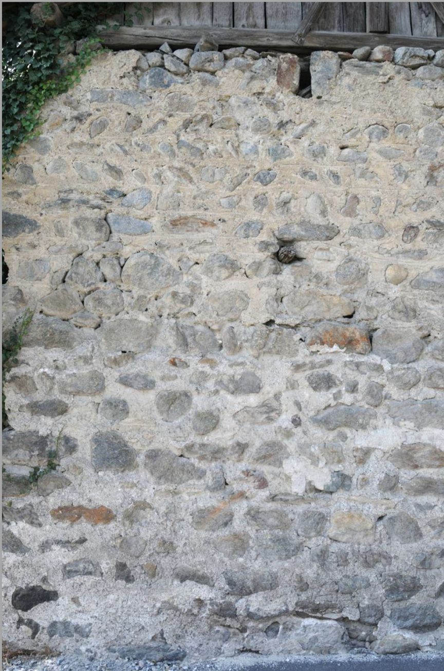
Mals / Südtirol Mauerwerk aus Findlingen (Kiesel) mit Fugenstrich Gerüstholzloch
