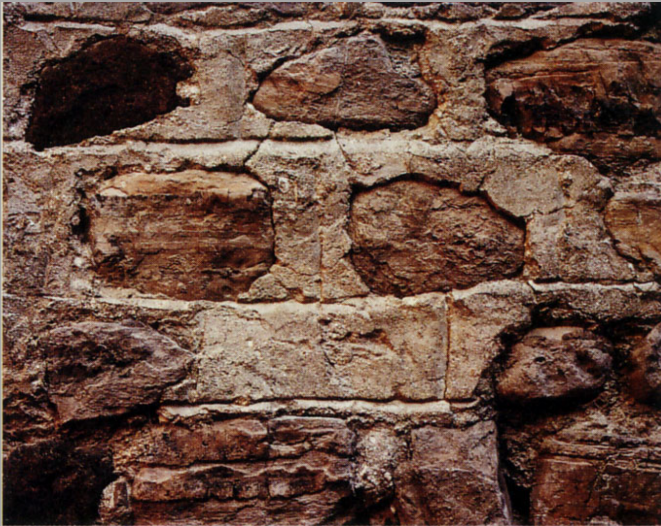
Riva San Vitale (Tessin/Schweiz) Baptisterium, um 500 n. Chr. Detail der Außenwandgestaltung mit Pietra-rasa- Verputz.
