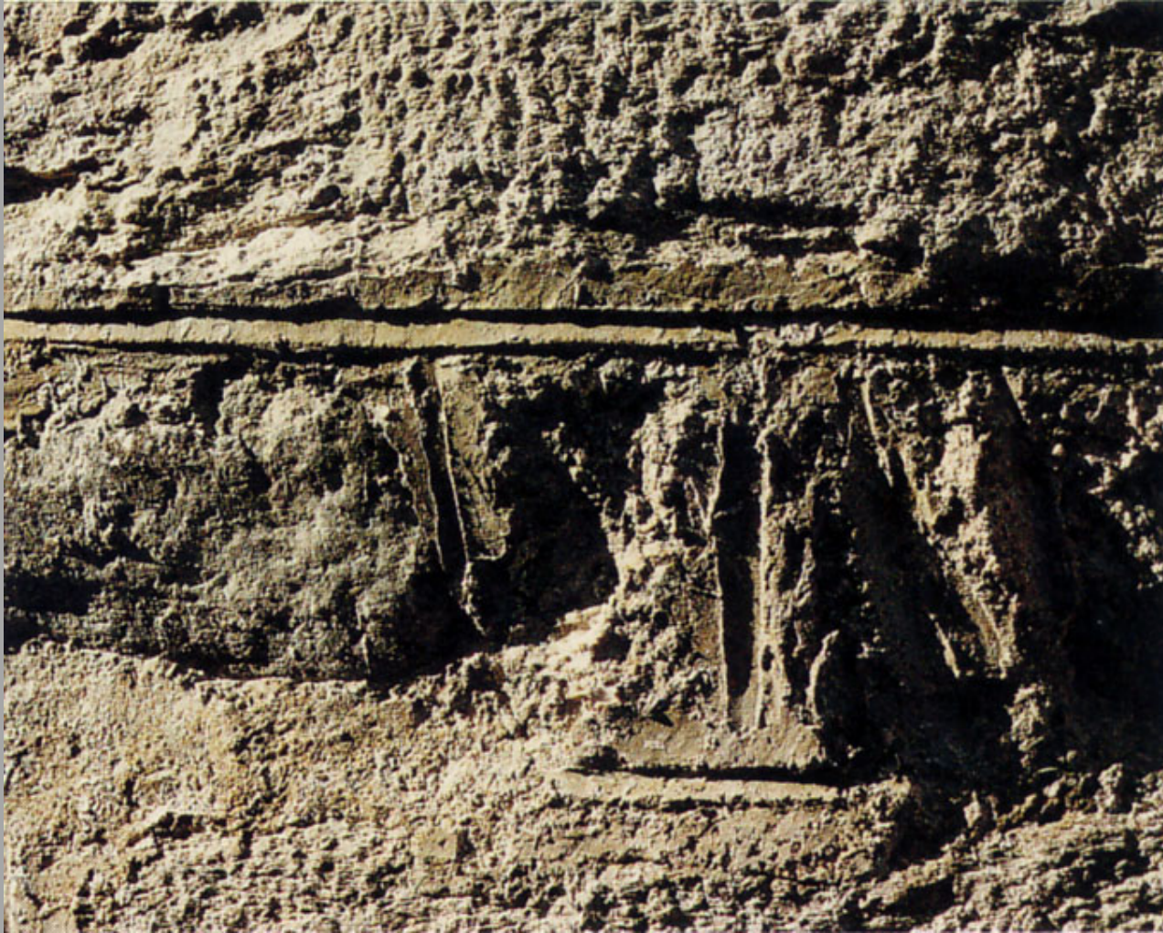
Pitasch (Graubünden/Schweiz) Kirche 12. Jahrhunderts. Detail des Pietra-rasa- Verputzes mit deutlichem Kellenstrich der nachträglich mit weißer Kalkfarbe herausgefaßt wurde. aus: Meyer, 1993
