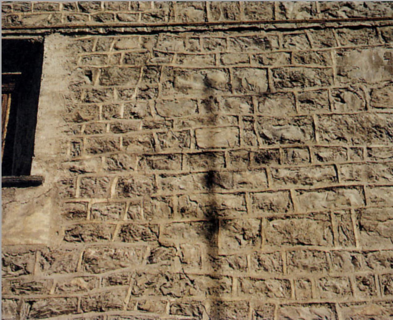
Bormio (Veltlin/Italien) Torre Alberti, 12. Jahrhundert. Detail des Mauerverbandes mit plastisch gestalteten Stoß- und Lagerfugen. aus: Meyer, 1993
