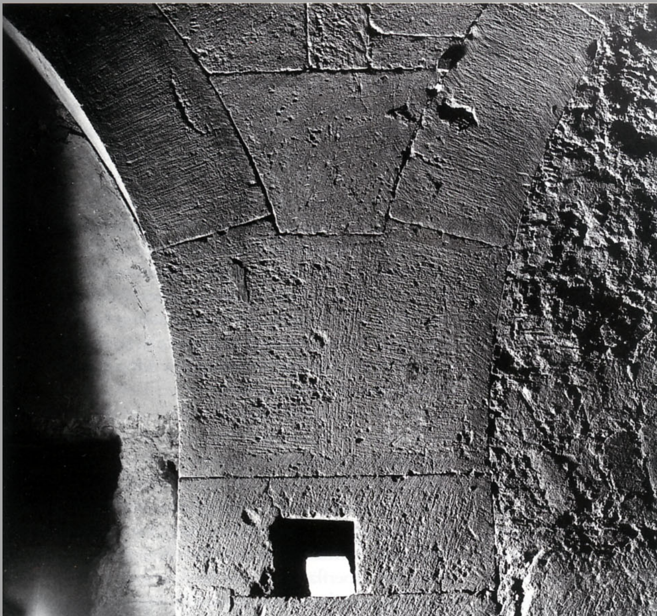
Bild 12. Weißensee – Runneburg innen, Festsaal-Südwand. Quader eines Arkadenzwickels mit richtungswechselnden, den natürlichen Steinversatz imitierenden Oberflächenstrukturen (schematische Darstellung des Befundes: R. MÖLLER)
