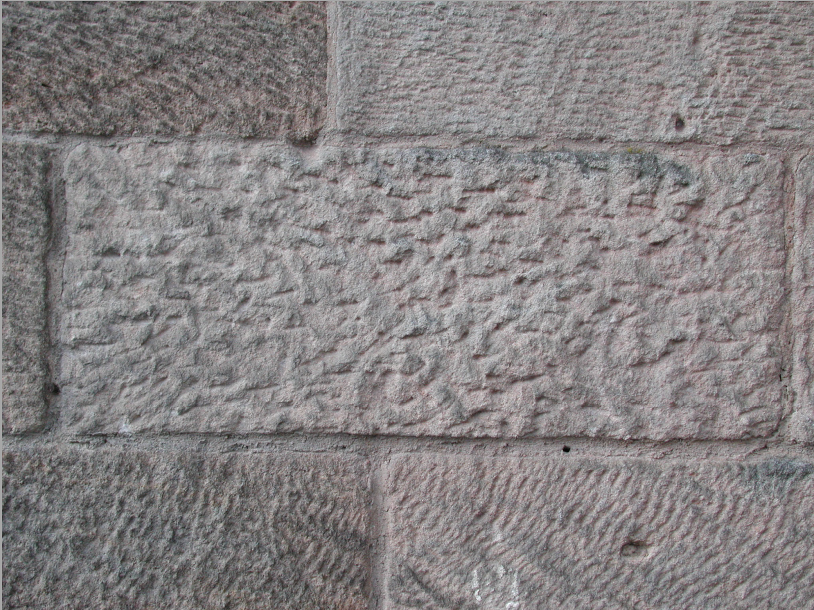
Mit dem Spitzeisen bearbeitete Oberfläche (Werkstein in der Mitte)
