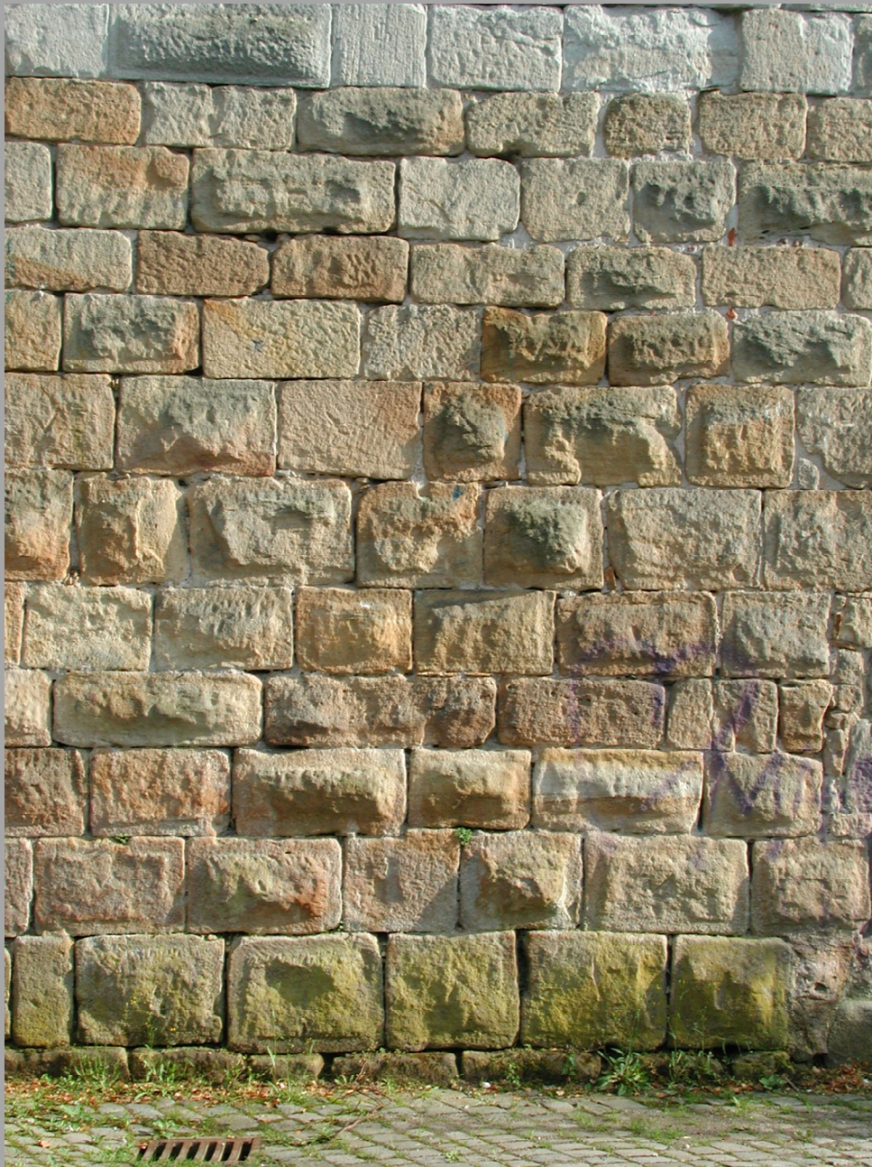
Esslingen, Burg Mauerwerk mit Buckelquadern
