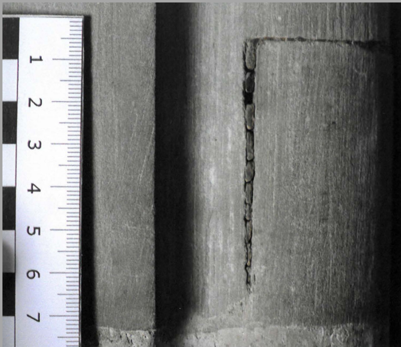
Abb. 197 + 198: Berner Münster, Chor (um 1440). Links eine eingeklebte Vierung/ Führung am querovalen Dienst. Die obere horizontale Fuge ist sehr schmal als Pressfuge ausgebildet, die Vertikalfuge etwas breiter ausgeführt. Auch das Bruckstück in der unteren Abbildung wurde mit Harz ange- klebt. Unklar ist, ob der Schaden während der Bearbeitung oder beim Versetzen entstand. Fotos: Berner Münster-Stiftung.
