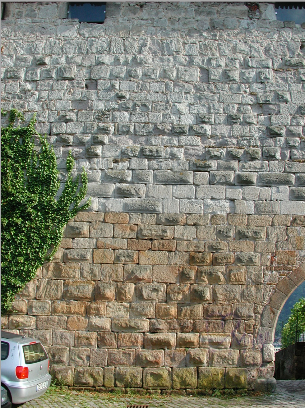
Esslingen, Burg Mauerwerk mit Buckelquadern
