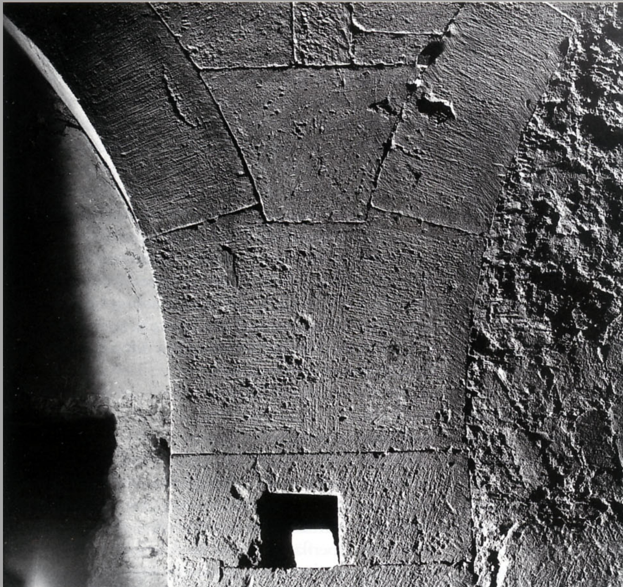
Bild 12. Weißensee – Runneburg innen, Festsaal-Südwand. Quader eines Arkadenzwickels mit richtungwechselnden, den natürlichen Steinversatz imitierenden Oberflächenstrukturen (schematische Darstellung des Befundes: R. MÖLLER)
