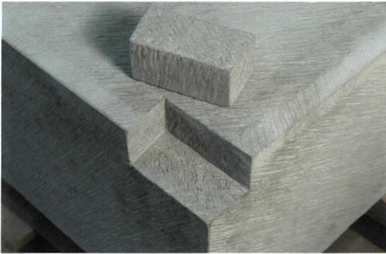
Abb. 200: Passgenaue Ausarbeitung der Vierung mit Pressfuge.
