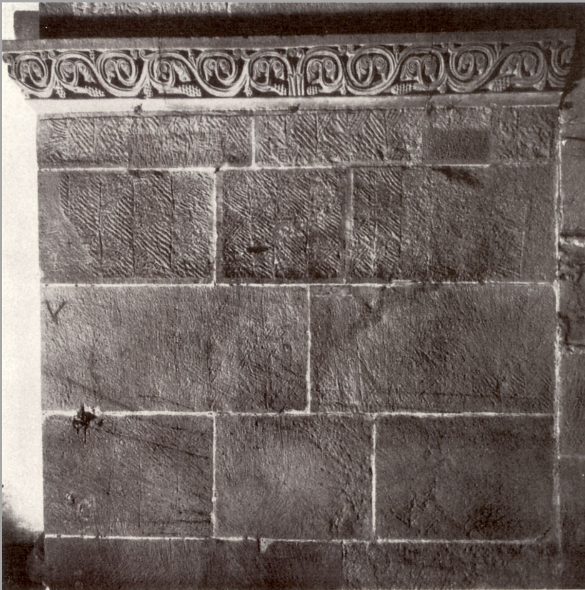
16. Münster zu Straßburg, Ostteil der Krypta. Nordwestlicher Eckpfeiler mit gemusterter Abspitzung, die auf den zwei unteren Schichten glatt überflächt ist.
