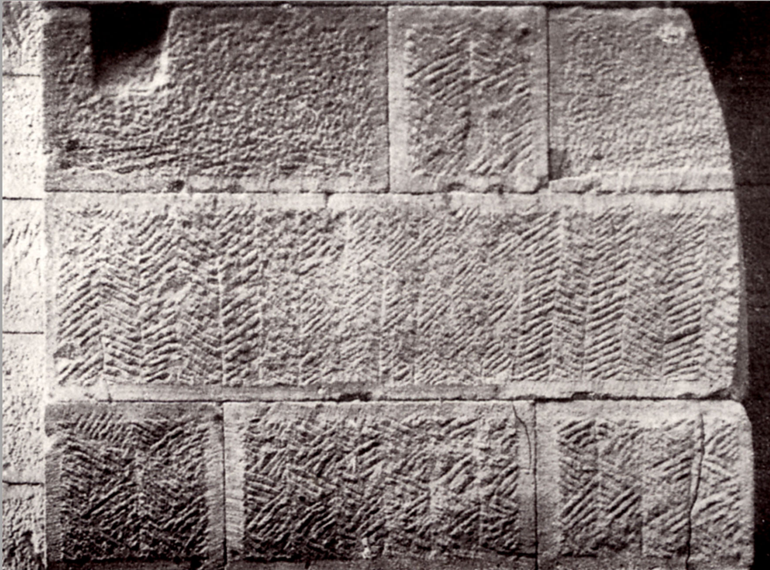
Gemustert abgespitztes Quaderwerk
