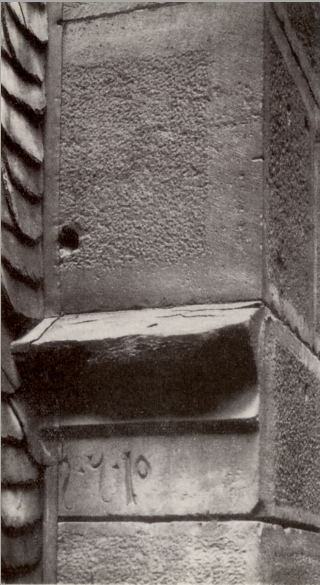
35. Münster zu Straßburg. Strebpfeiler von 1510 mit aufgespitzten Quaderspiegeln.
