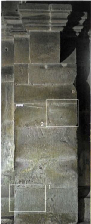
Abb. 148: Maulbronn Klosterkirche. Stirnseite einer Kapellentrennwand, um 1150. Bearbeitungsstufen VI und VII.
