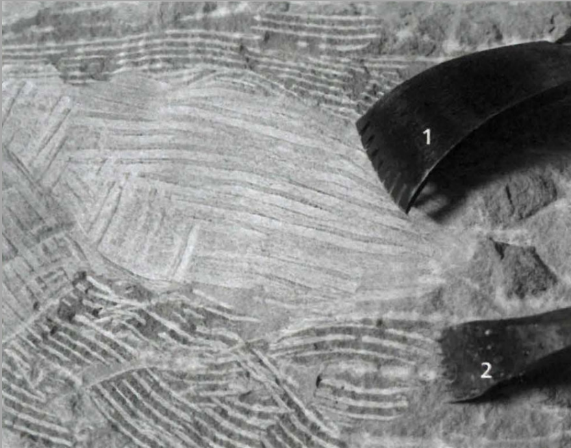
Abb. 190: Das Schabeisen ( 1 hier mit 3 cm Breite und acht Zähnen) ergibt durch die ziehend-schabende Bewegung ein anderes Oberflächenbild als das vorwärts angetriebene Zahneisen ( 2 ).
