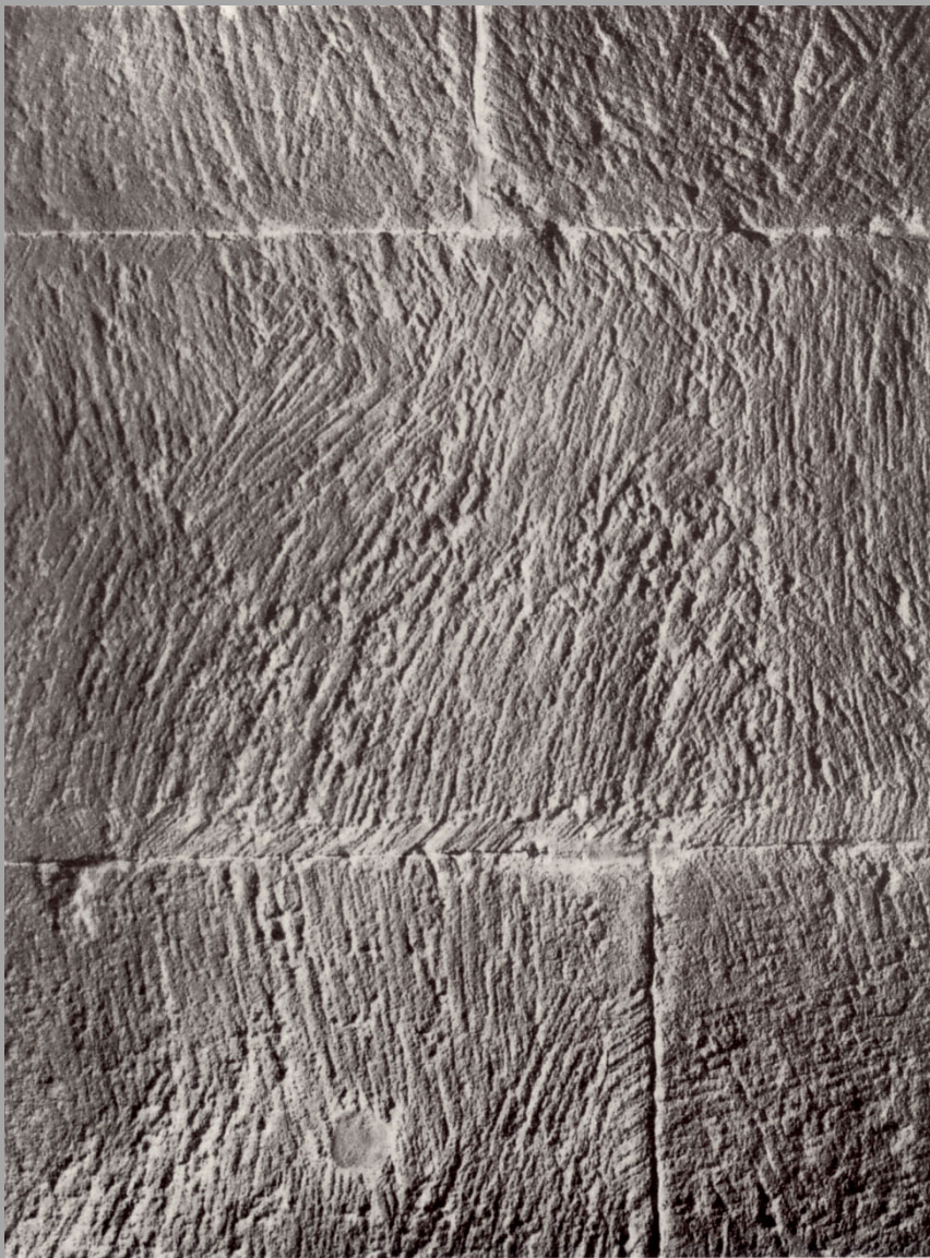
9. Münster zu Straßburg. Mit Glatfläche abgearbeitete Quader von einem Freipfeiler der östlichen Krypta. aus: Friederich, K., 1988
