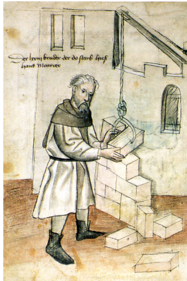
Der Maurer (mawrer) setzt auf eine angefangene Mauer einen noch in der Zange an einem Auslegerkran hängenden Quaderstein. (fol.31v)
