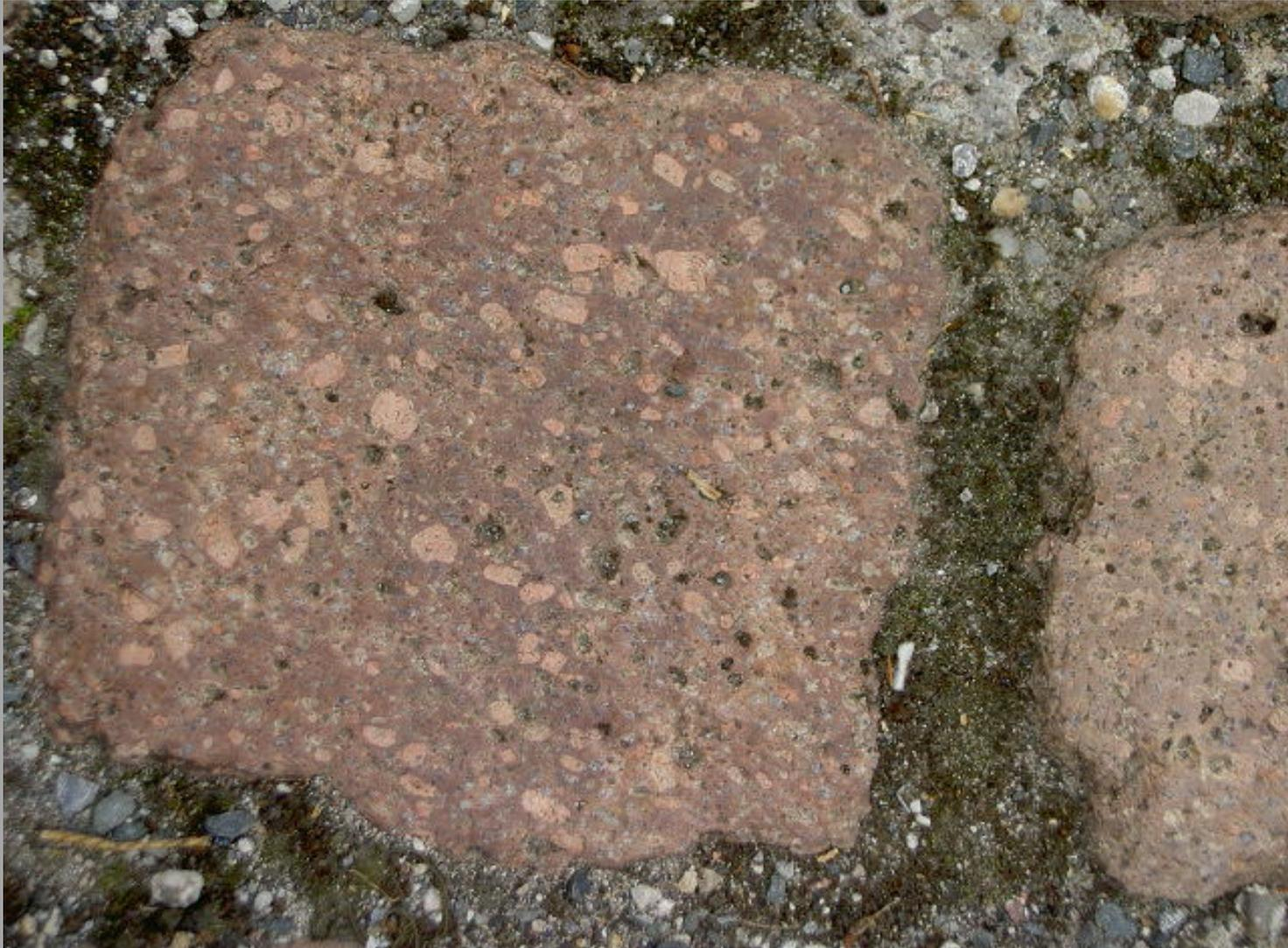
Kleinpflaster aus Löbejüner Rhyolith (verlegt in Hasselfelde/Harz)
