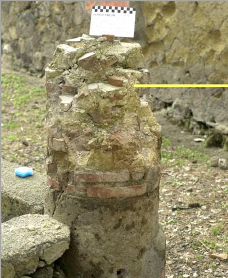
Aus Ziegel- und Tuffgesteinsegmenten aufgemauerter Stützenkern
