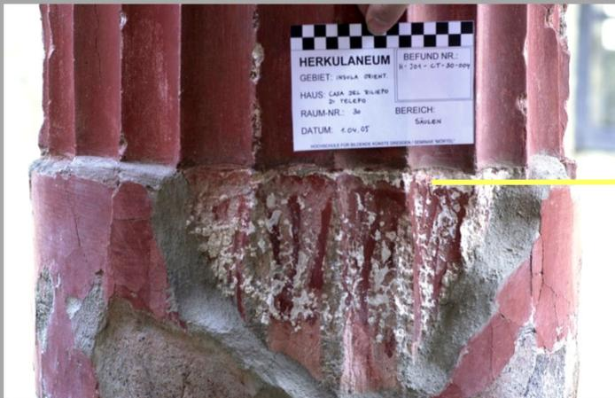
Übergang zwischen Kannelierung zum Sockelbereich einer stuckierten und rot bemalten Stütze
