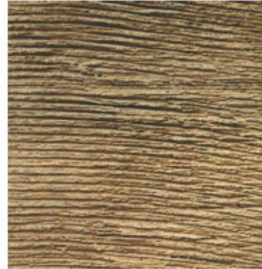
Abb. 35: horizontal gezogener Besenstrichputz
