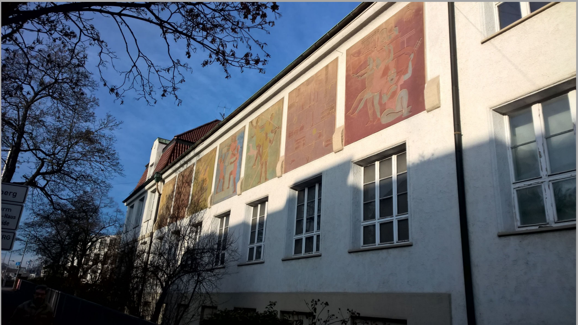
ABK Stuttgart, Altbau, Südfassade (Malersaal)
