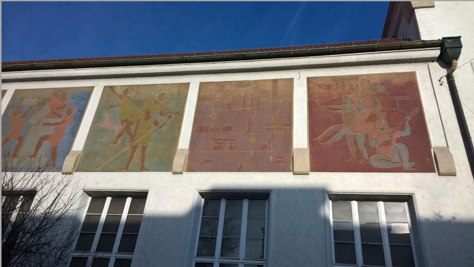
ABK Stuttgart, Altbau, Südfassade (Malersaal)
