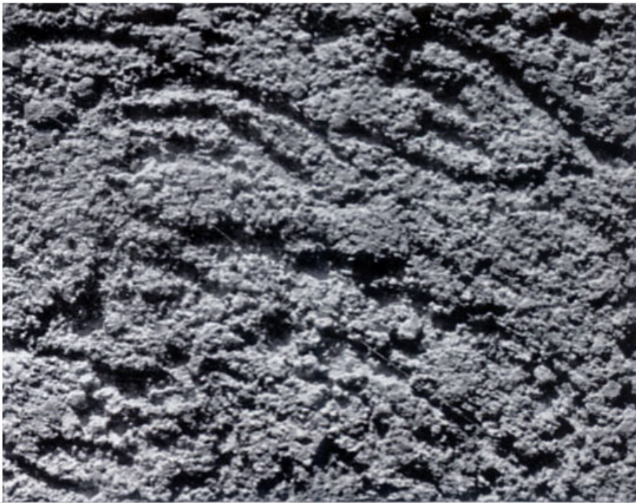
Rund verriebener Putz
