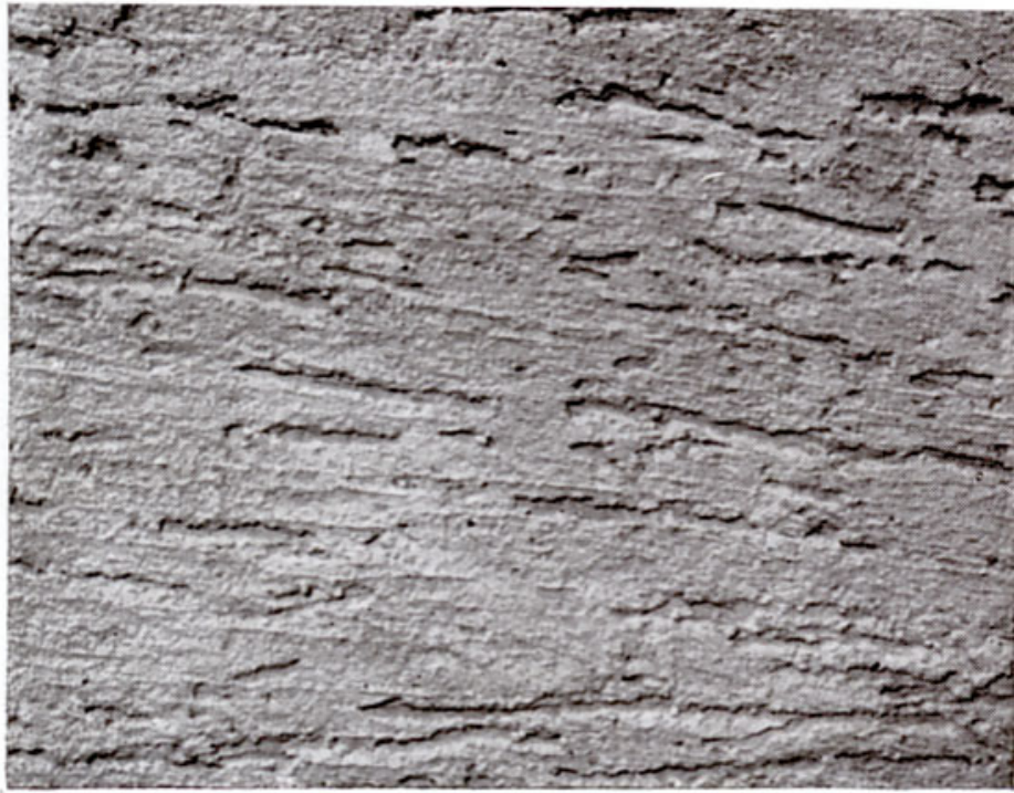
Waagrecht verriebener Putz aus Sand mit feiner Körnung
