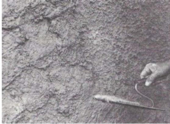
Abb. 9: Anwerfen des Mörtels mittels Kelle
