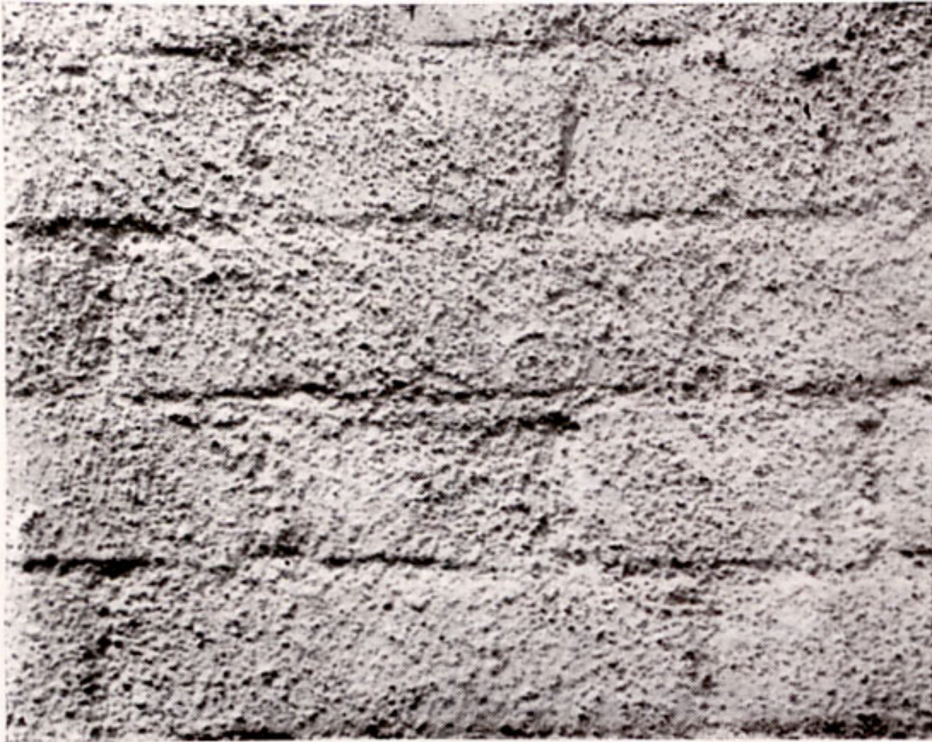
Schläämputz auf Ziegelmauerwerk
