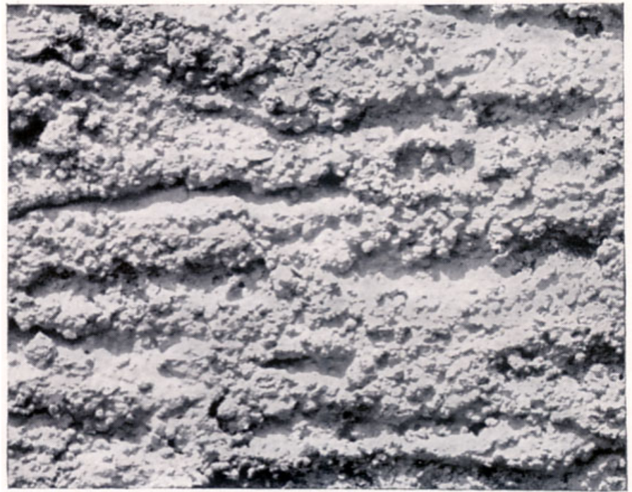
Waagrecht verriebener Putz aus Sand mit grober Körnung
