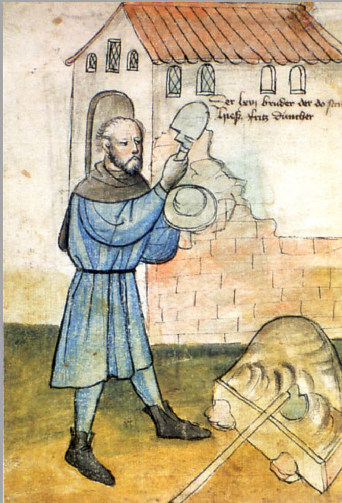
Der Putzer (Düncher) steht an der Traufseite eines ziegelgedeckten Hauses und verputzt von gestielter Palette mit der Kelle die Ziegelmauer, vorn rechts erkennt man einen Mörtelkasten mit Speishau. (fol. 30v)
