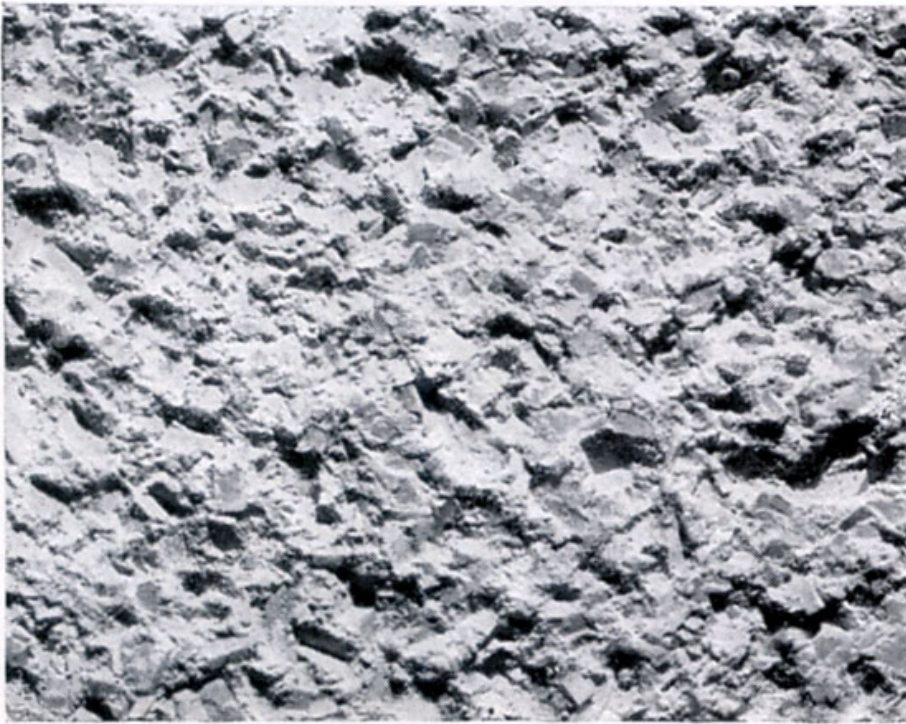
Kratzputz aus gequetschtem Material feinerer Körnung
