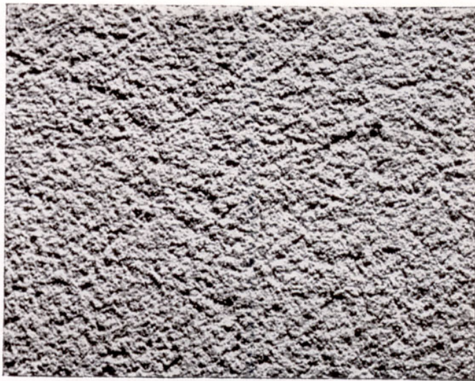
Kratzputz aus natürlichen Zuschlagstoffen (feinkörniger Sand)
