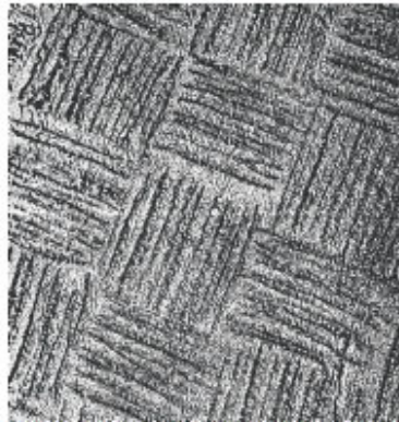
Abb. 36: Gekämmter Putz schräg wechselnd mit Hohlkamm gezogen
