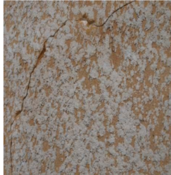
Abb. 8: Ein Sonderfall ist die Kombination aus Reibeputz und einer Besenspritzputztechnik am Landhaus Abraham (s. Objekt-Nr.: 2501)
