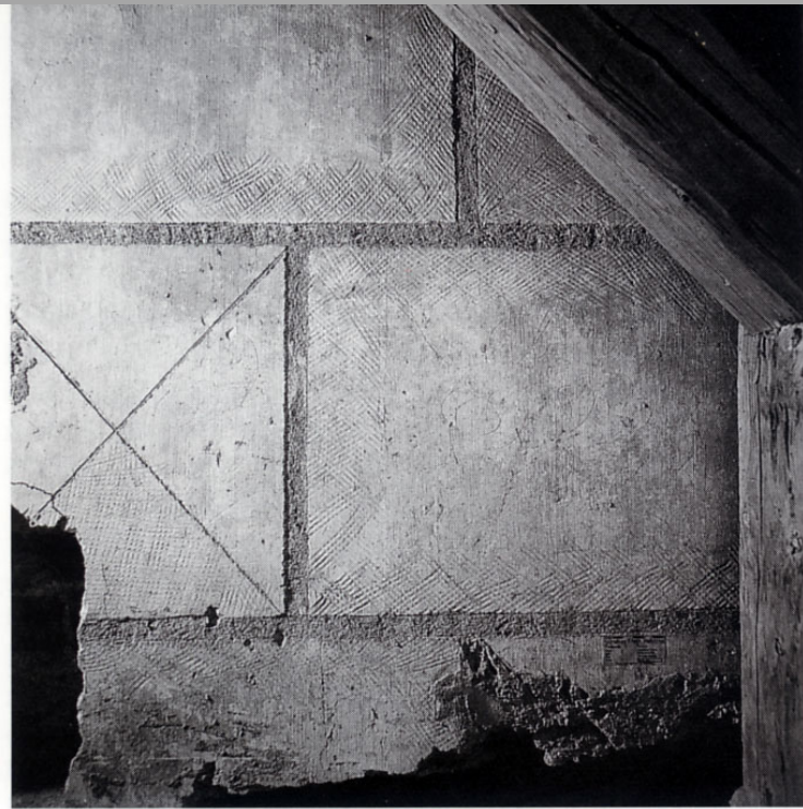
Abb. 13. Günzburg, ehem. Hofkirche, ca. 1609, Westseite unter barockem Anbau, geglätteter und getünchter Putz, Fugen in Sgraffitotechnik herausgekratzt, „Schattierung“ (Modellierung) der fingierten Diamant- und Bossenquader mit einem Zahneisen in der weichen getünchten Oberfläche (Foto: Hacklberger)
