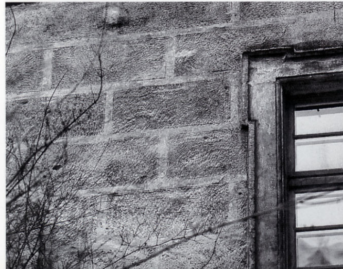
Abb. 15. Thurnau, Lkr. Bamberg, Schloss, 1690, auf angeglättetem Putz Ritzung des Fugensystems, Aufrauung der Quaderbinnenflächen und Stupfen mit einem Nagelbrett, erkennbarer Rapport (Foto: Pursche)
