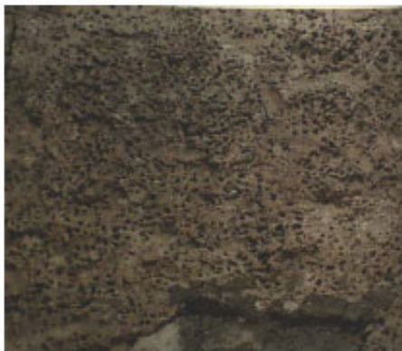
Abb. 44: Kombination aus Kellenwurf-Struktur und Rutenbesenstipp-Strukturen
