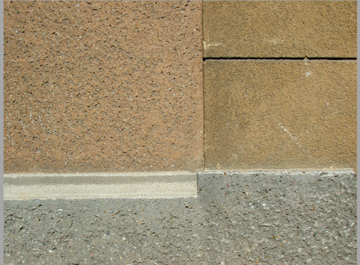
Potsdam ehemalige Stadtverwaltungsstelle Potsdam-Land Edelputz Kratzputz
