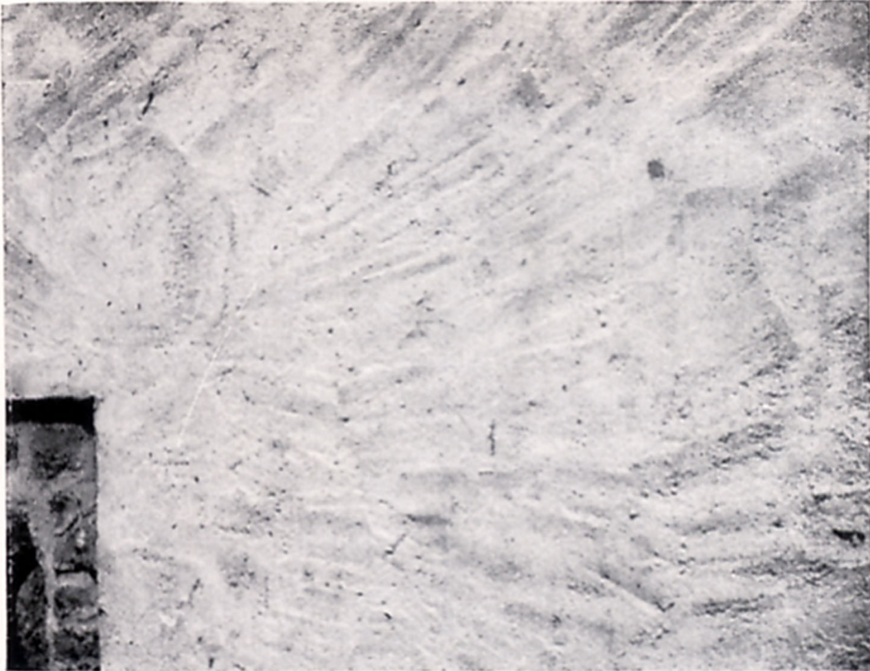
„Althistorischer“ Putz, mit der Kelle bearbeitet
