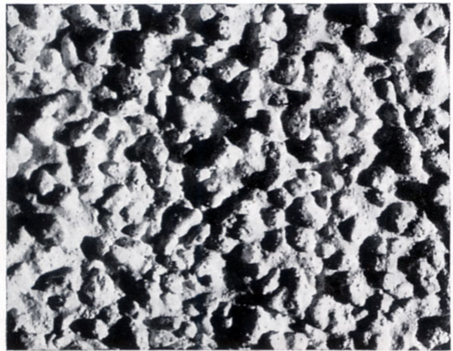
Kellenspritzputz mit gröbem Korn
