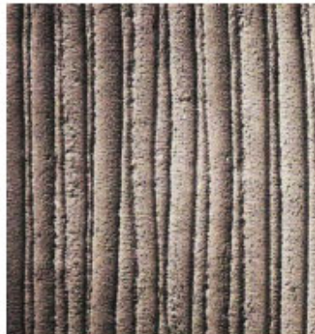
Abb. 38: Mit Gummikamm gezogener Putz
