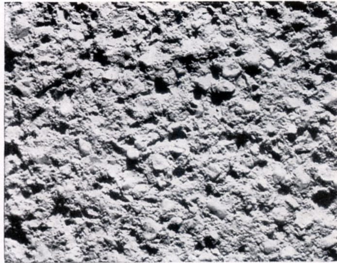
Kratzputz aus natürlichen Zuschlagstoffen (grobkörniger Sand)
