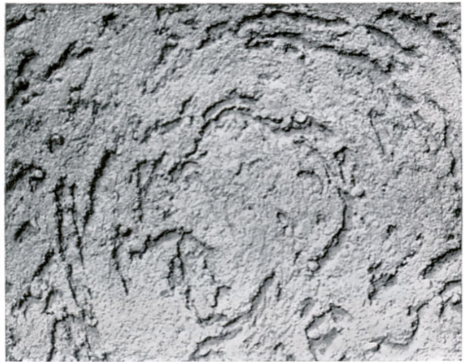
Rund verriebener Putz
