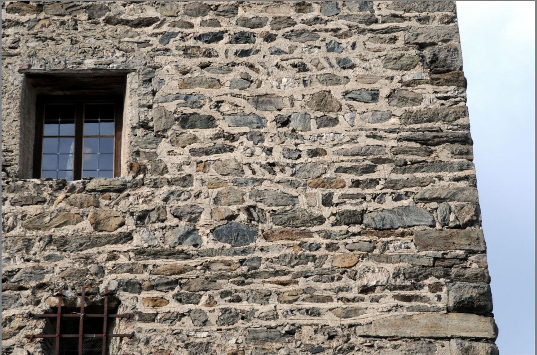
Schloss Landeck (Österreich), Hausteinmauerwerk, Eckquaderung, z. T. mit gut ausgeformten Werksteinen, Fugen mit Fugenstrich
