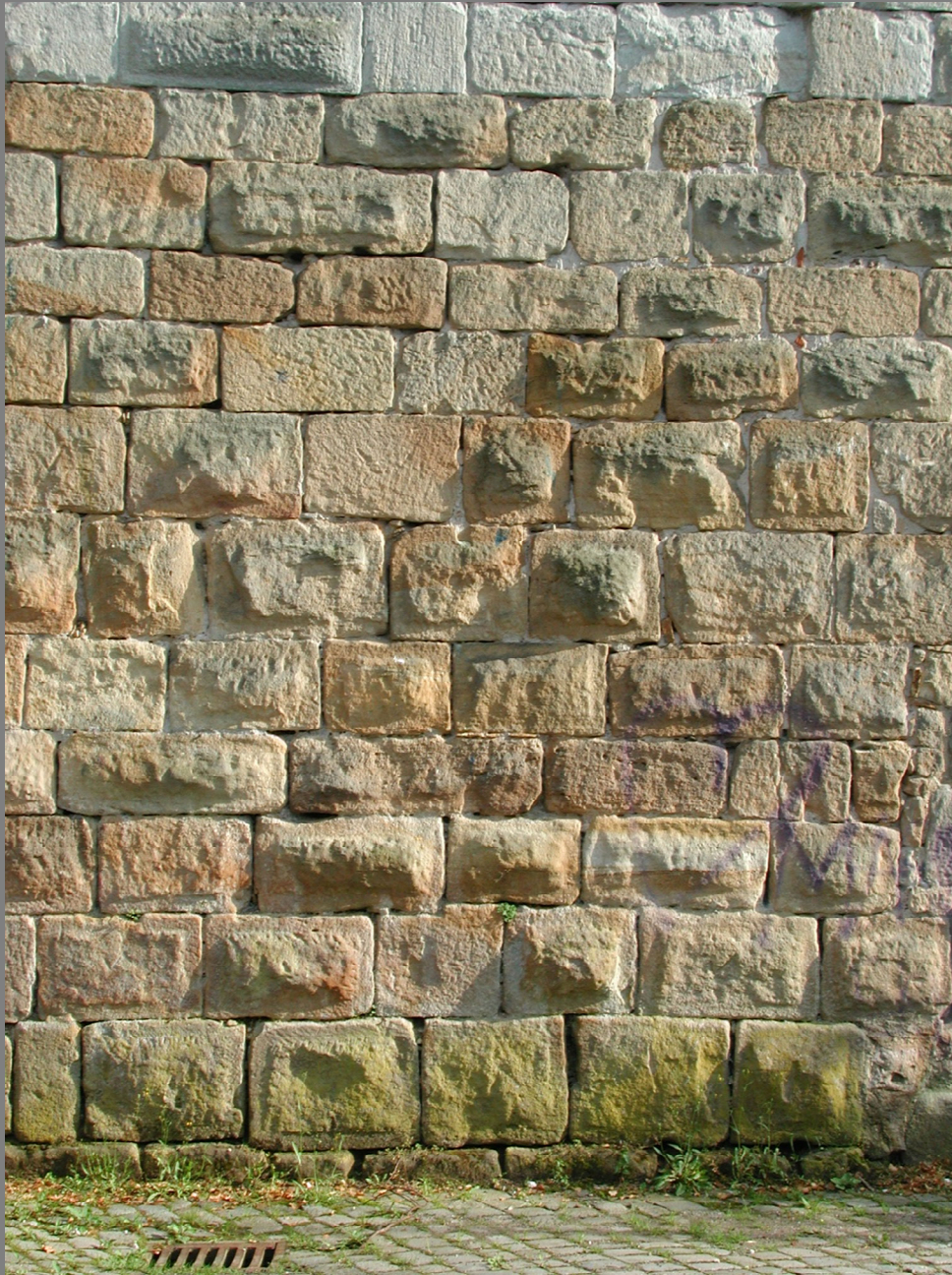
Esslingen, Burg Mauerwerk mit Buckelquadern
