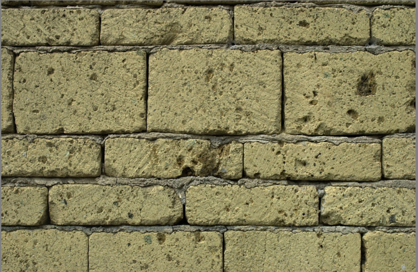
opus pseudoisodomum aus Tuffsteinblöcken, San Angelo in Formis, Italien
