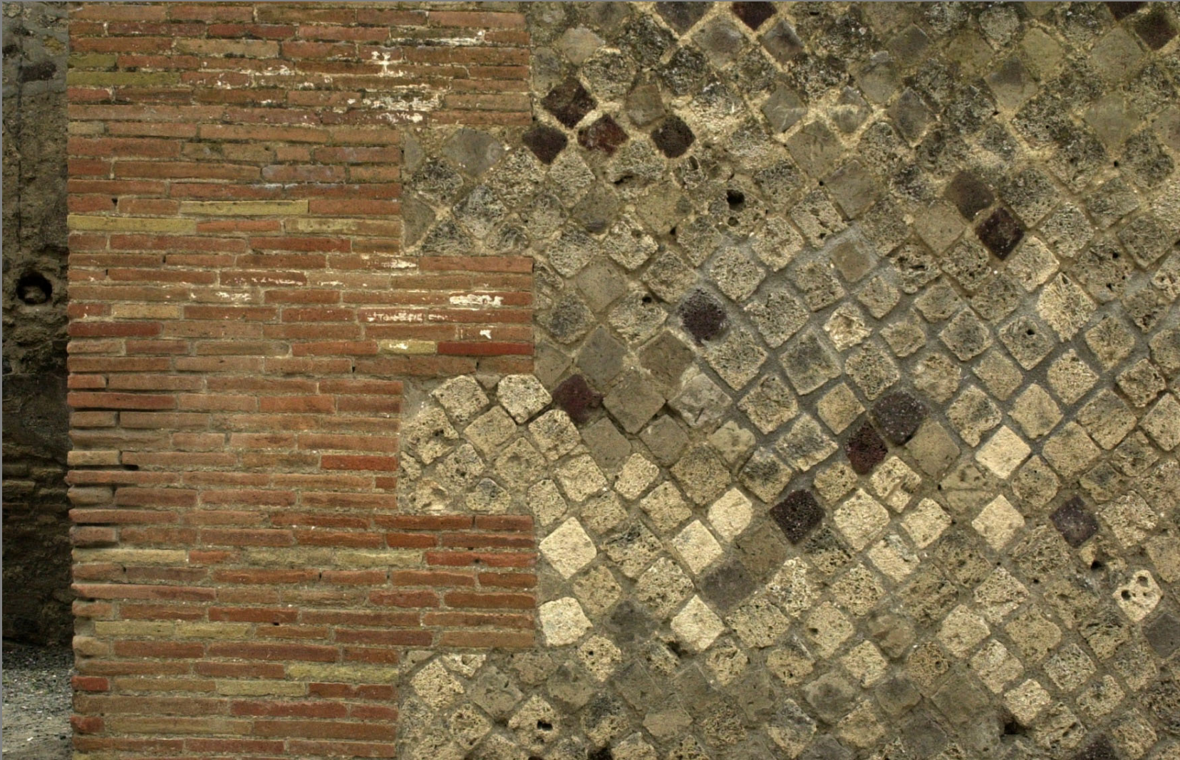
opus reticulatum und in Ziegelmauerwerk ausgeformte Ecksituation / Herculaneum
