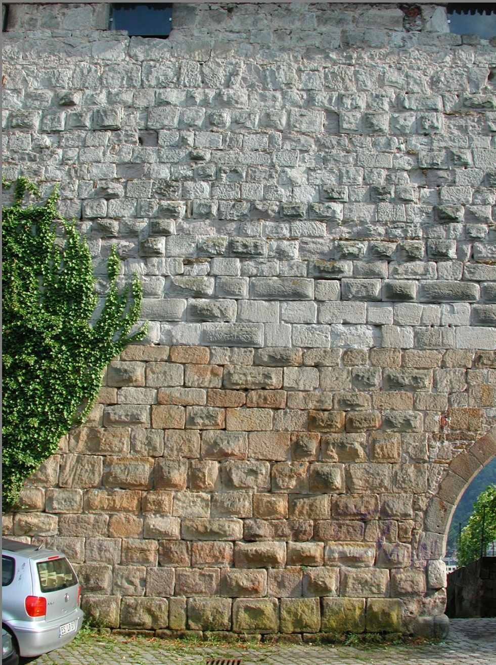
Esslingen, Burg Mauerwerk mit Buckelquadern
