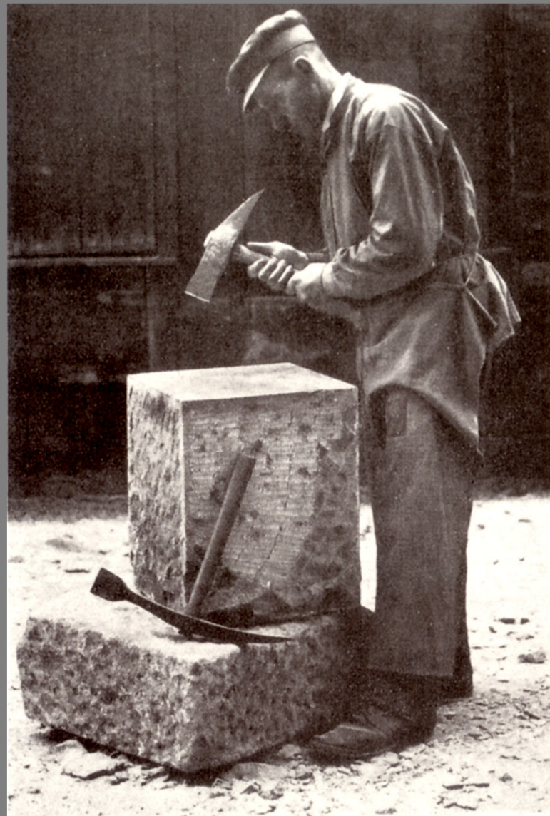
11. Das Abflächen auf der Bank mit der Spitzfläche von frühe Form; an der Bank eine Spitzfläche später Art.
