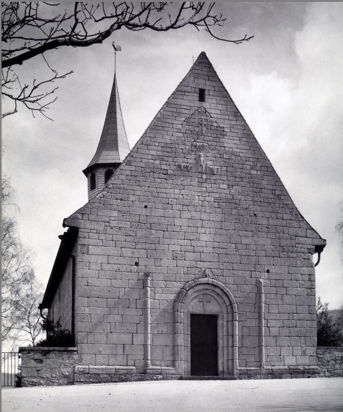
Mössingen-Belsen Ev. Pfarrkirche Westfassade Mitte 12. Jh.
