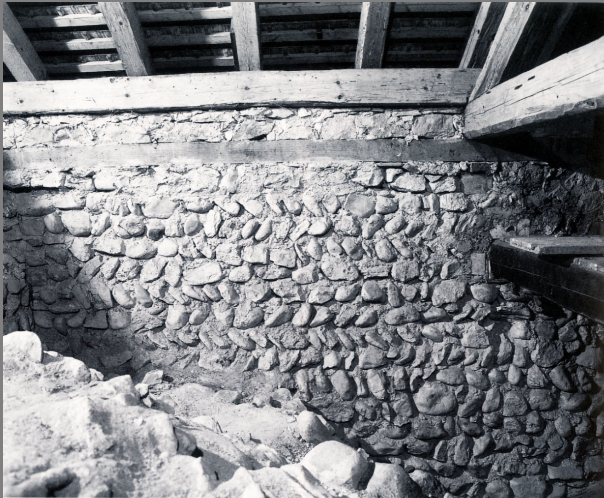
bb. 64 Nordseite, Dachraum des nördlichen Seitenschiffs: Ihrenverband der neu aufgemauerten Seitenschiffnordwand (3/1996).
