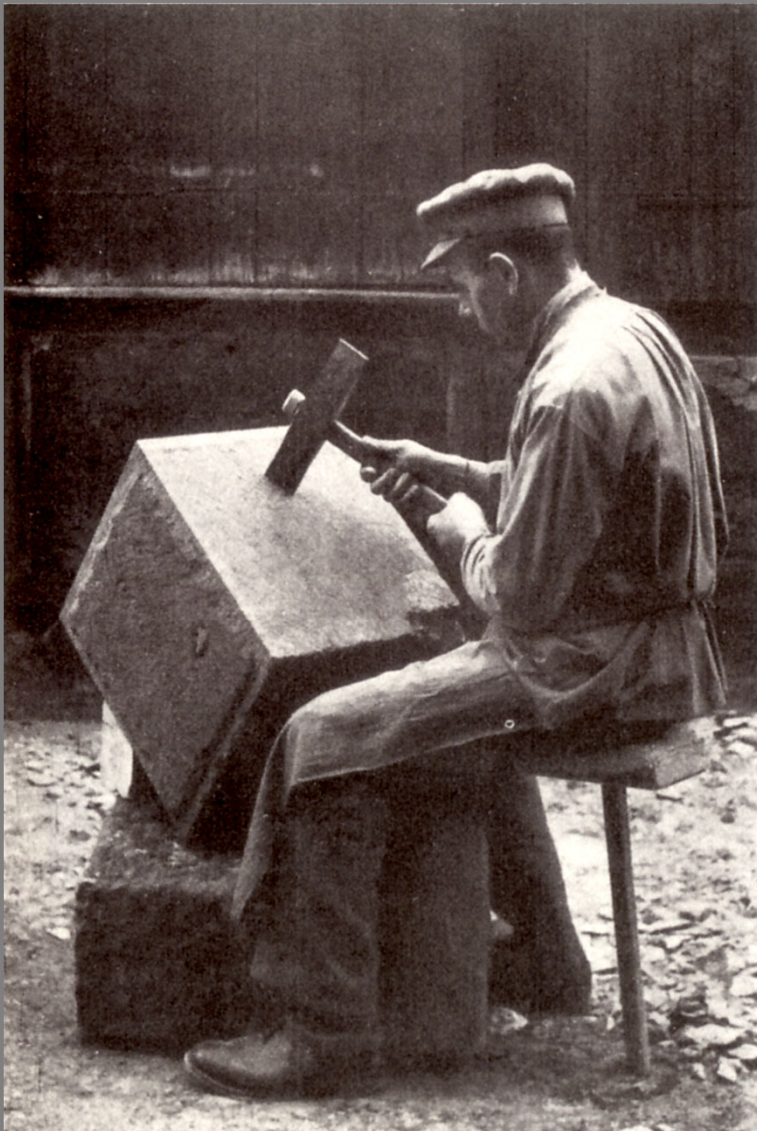
12. Das Pillen in Schräglage mit der glatten zweischneidigen Fläche.
