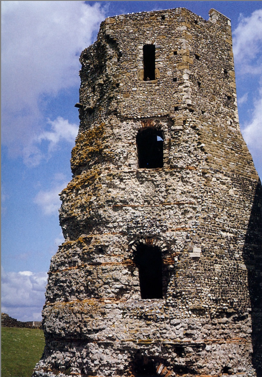
Bild 122: Leuchtturm in Dover/England; er besteht aus opus caementitium und ist das älteste, nahezu erhaltene römische Bauwerk in England (um 50 n. Chr.).
