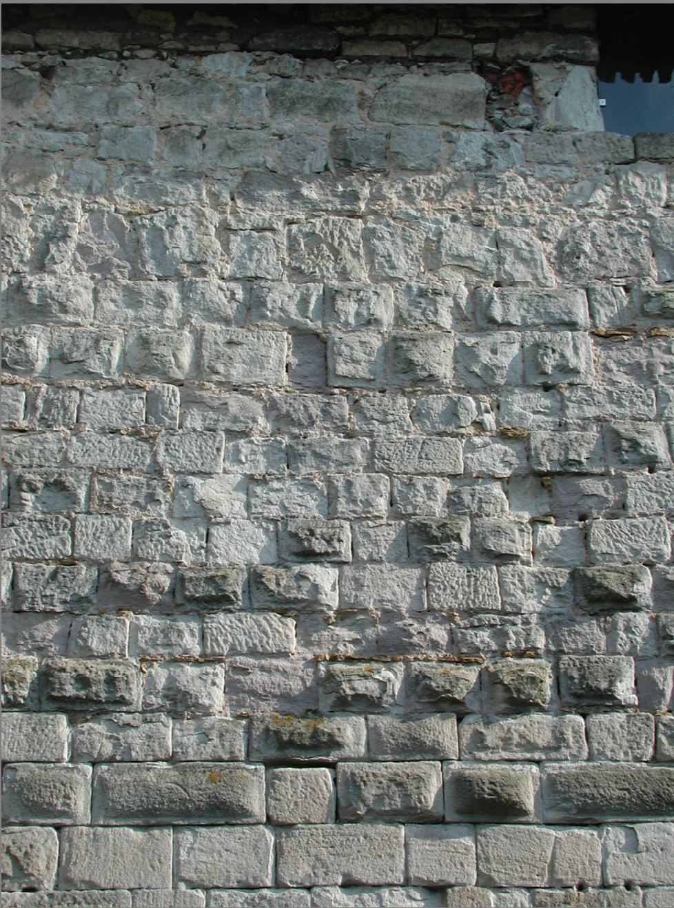
Esslingen, Burg Mauerwerk mit Buckelquadern
