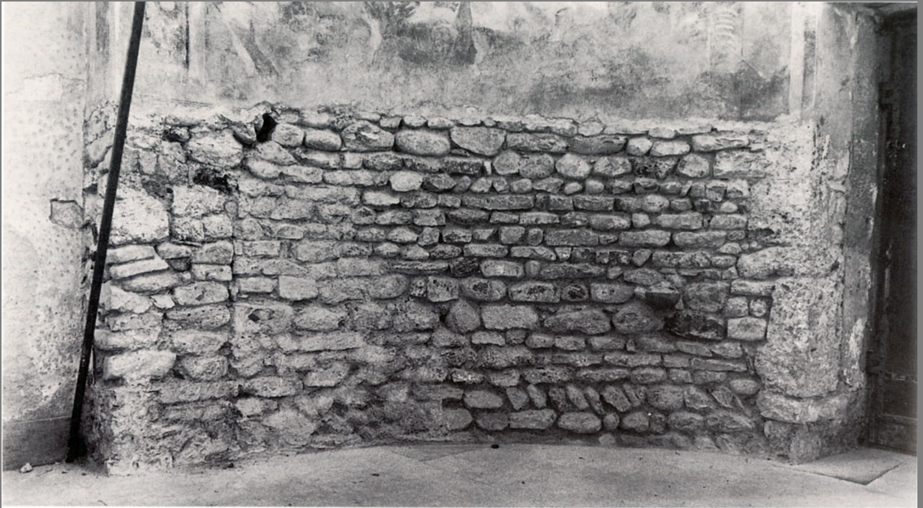
Abb. 113 Westapsis, südlicher Teil, Mauerwerk der Sockelzone (1984).
