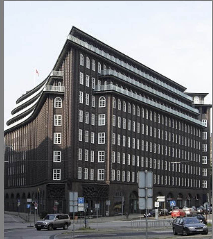
Hamburg, Chilehaus (1922-1924) von Fritz Höger
