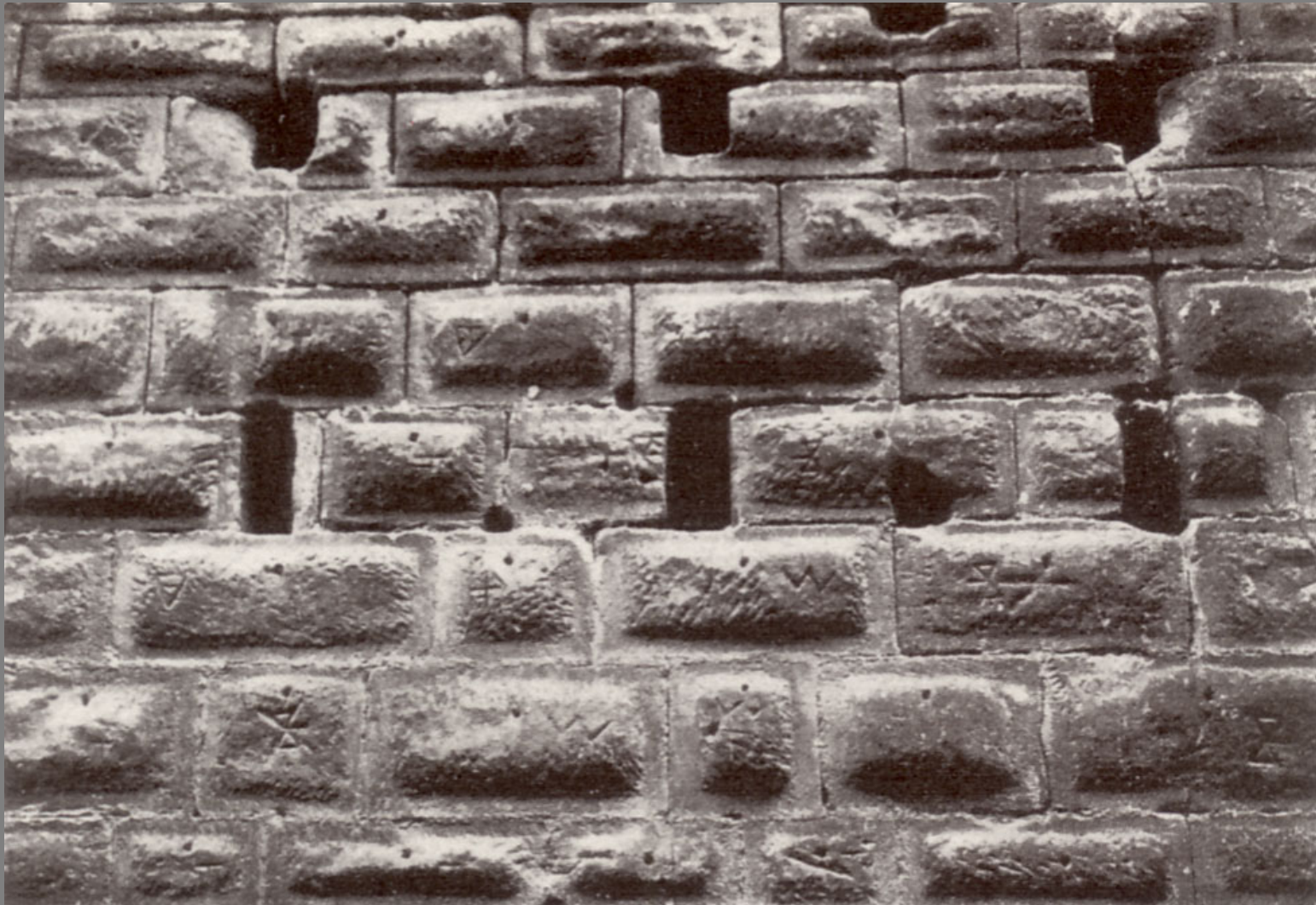
Wasserturm beim Henkersteg in Nürnberg. Buckelquader mit Steinmetzzeichen
