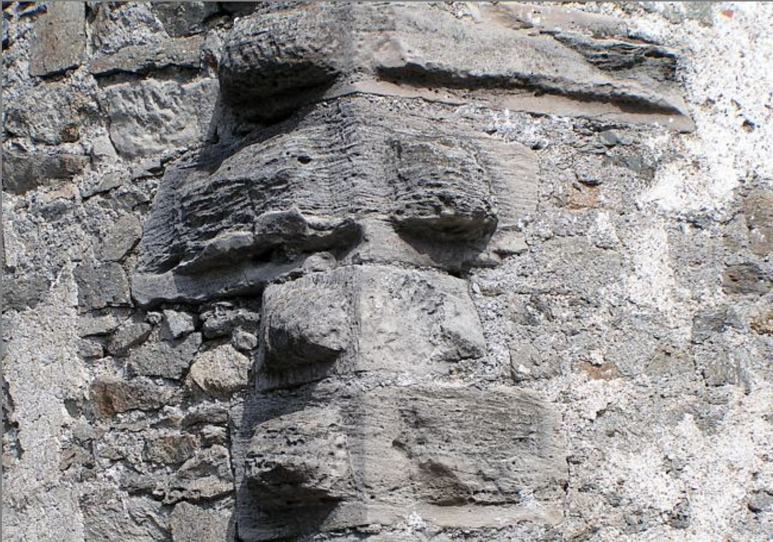
Forchtenstein - BGL Buckelquader an der Kante des mit einem Keil versehenen Rundturmes wahrscheinlich erst 14. Jh.
