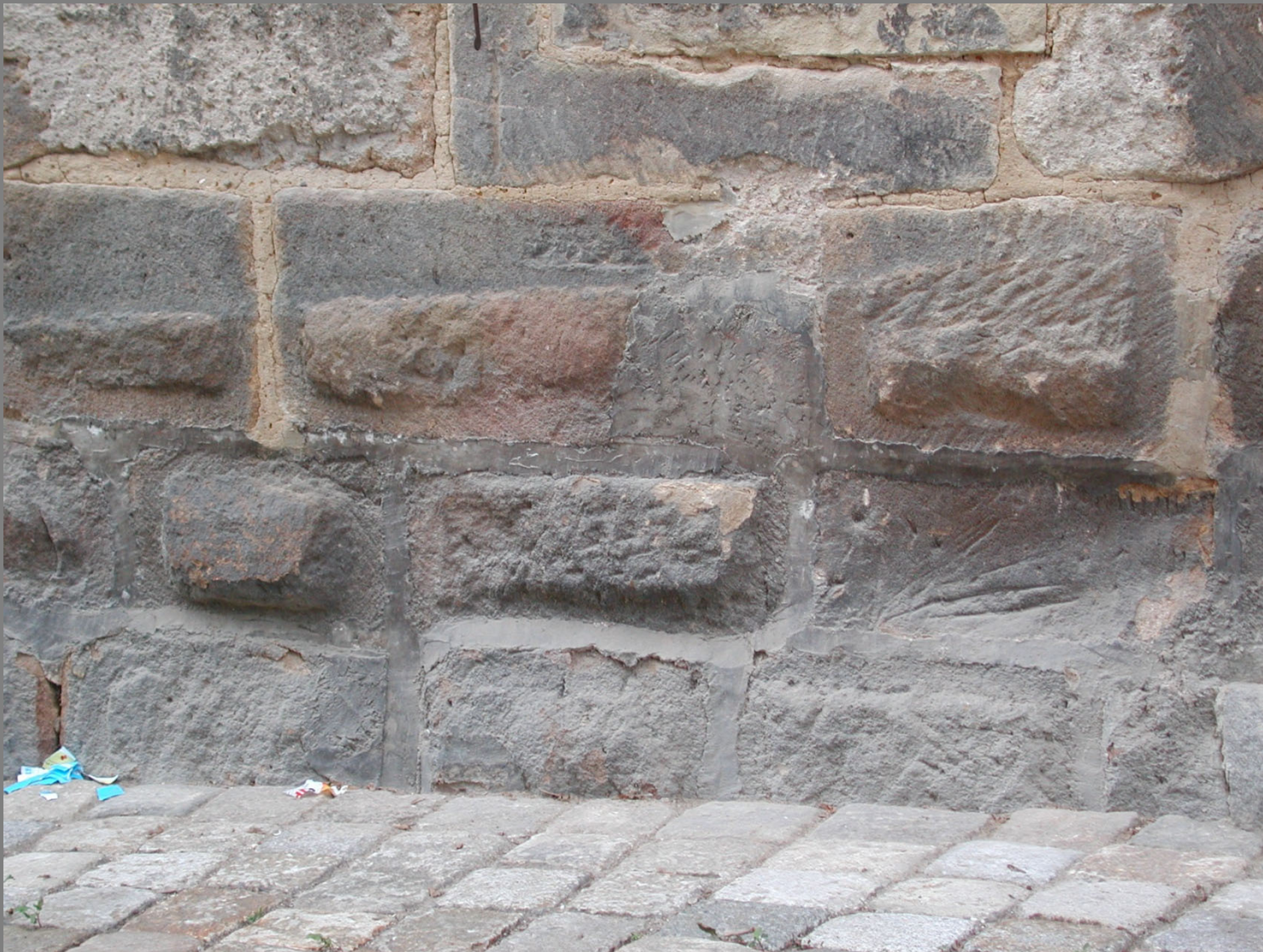
Esslingen, Zehntgasse / Rückseite von Marktplatz 21 (ehem. Speyrer Pfarr- und Zehnthof), Buckelquader, z. T. abgearbeitet
