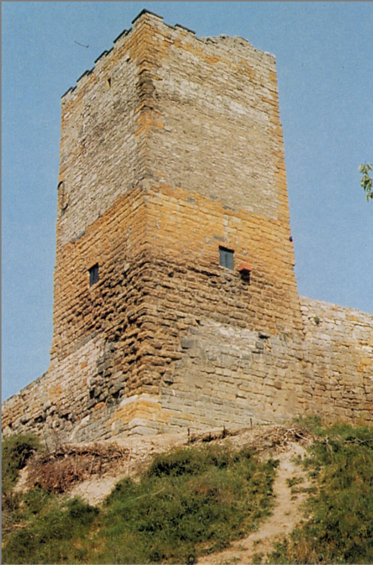
Abb. 15. Burg Gleichen bei Wandersleben (Krs. Gotha, Bergfried, Süd- und Ostseite in verschiedenen Mauerwerksarten: Buckelquader und Werksteine aus Kalkstein und Keuperdolomit im farbwechselnden Versatz (Foto: Verf.).
