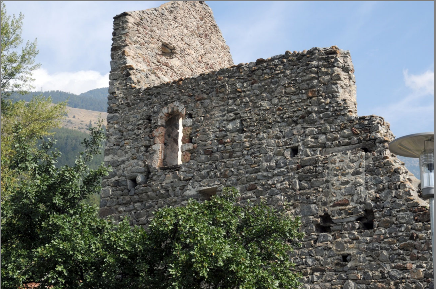
Mals / Südtirol / Burgruine Fröhlichsburg, 12. und 13. Jahrhundert lagerhaftes Feldstein und Hausteinmauerwerk mit dünnen Ausgleichsschichten
