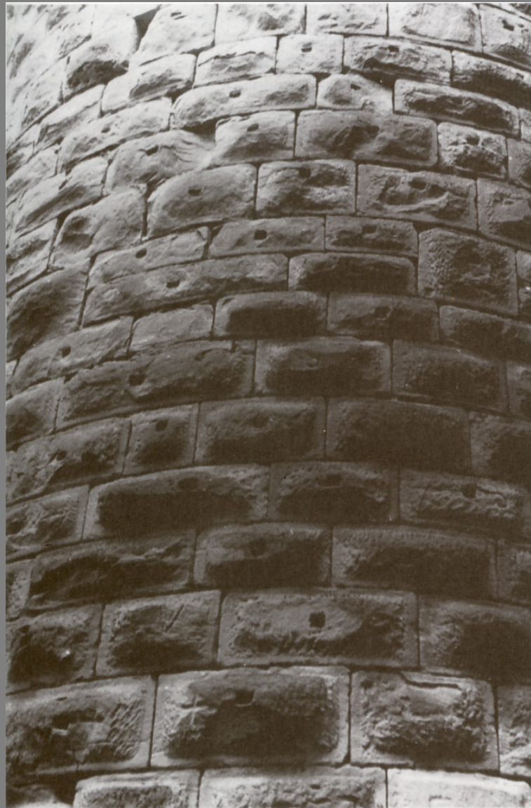
Abb. 14. Wallenburg bei Awallenburg (Krs. Schmalkalden), Bergfried mit kissenartigem Buckelquadermauerwerk in Kalkstein (Foto: Verf.).
