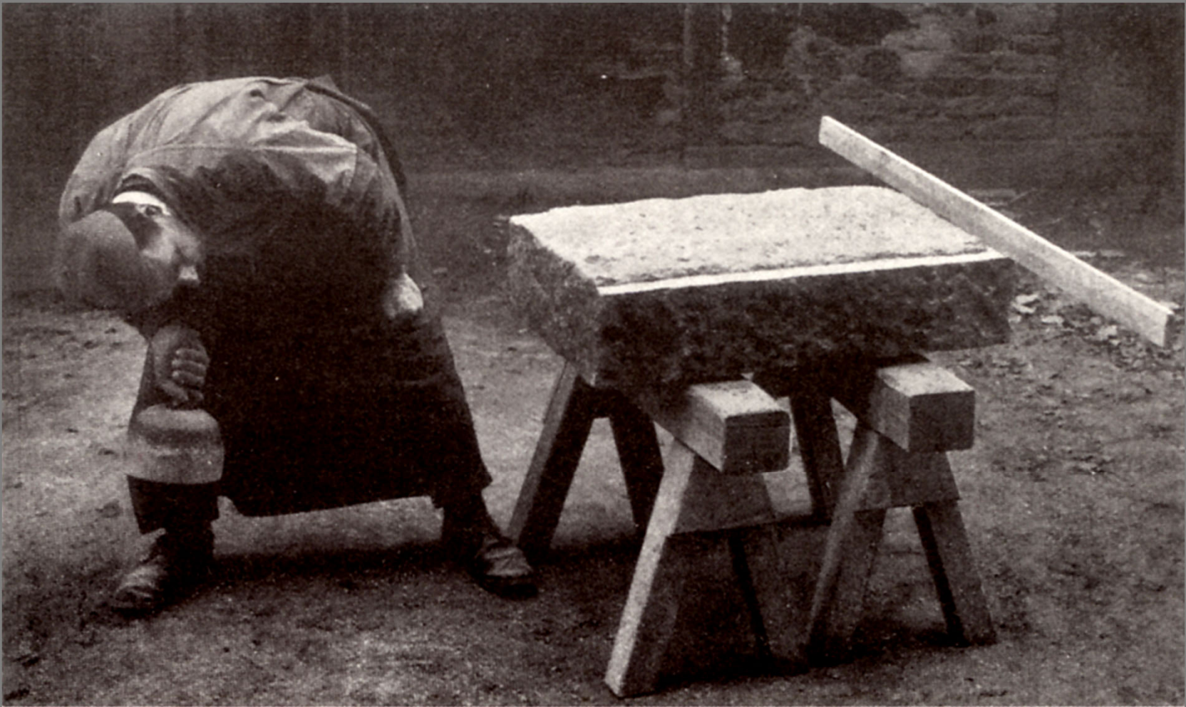
Grob zugearbeiteter Werkstein mit Randschlag.
