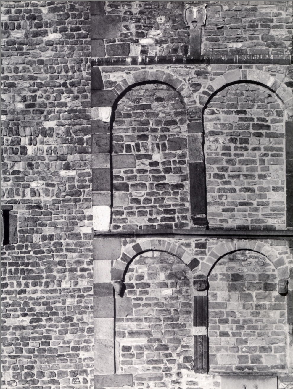
Ladenburg Sebastianskapelle Wandstück des romanischen Vorgängerbaus auf der Nordseite (frühes 12. Jh.)
