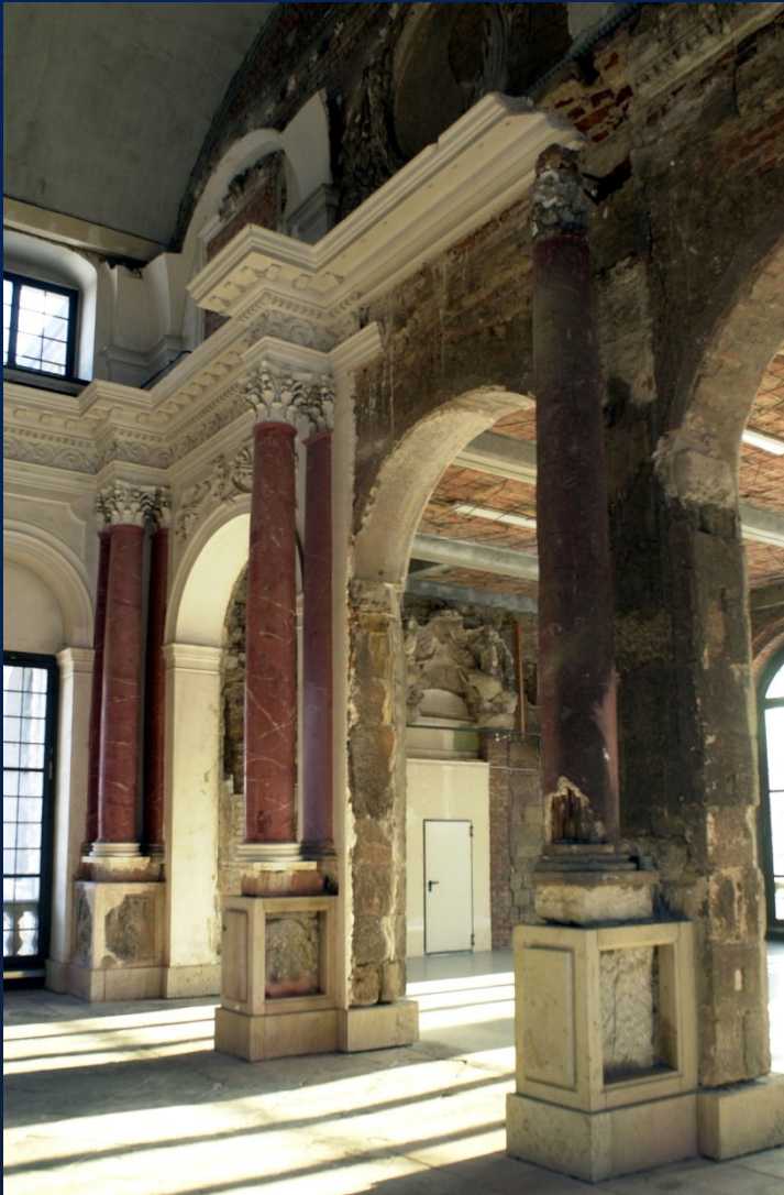
Einzige überkommene Stuckmarmorsäule im Festsaal, links die Rekonstruktionsprobe von 1968/74
