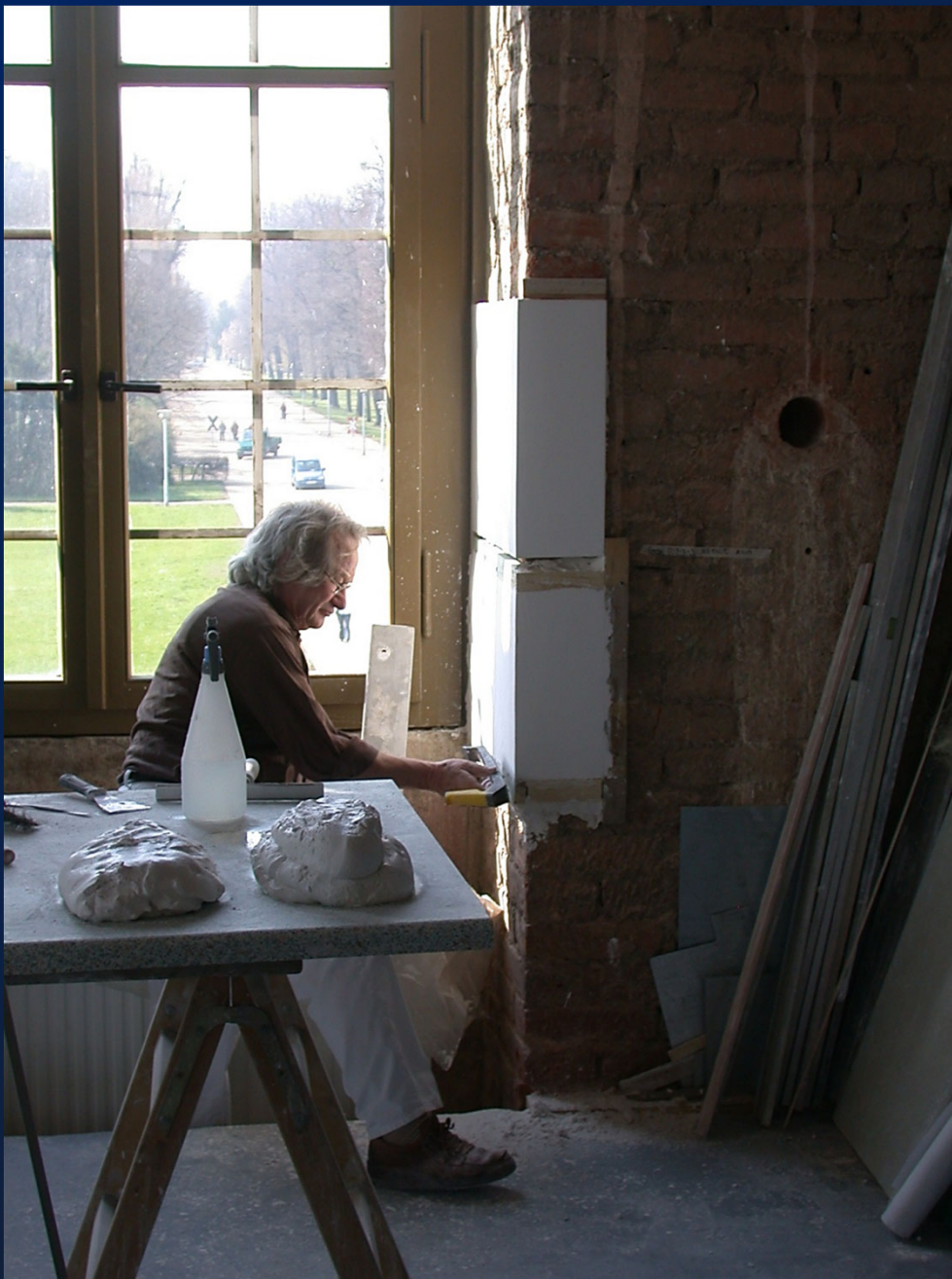
Manfred Siller (†) im Palais im Großen Garten zur Herstellung von Stuckmarmormustern und Glanzstuck aus Hochbrandgips (um 2007)
