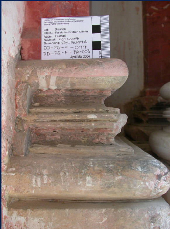
Pilaster im Festsaal. Befundstelle.
