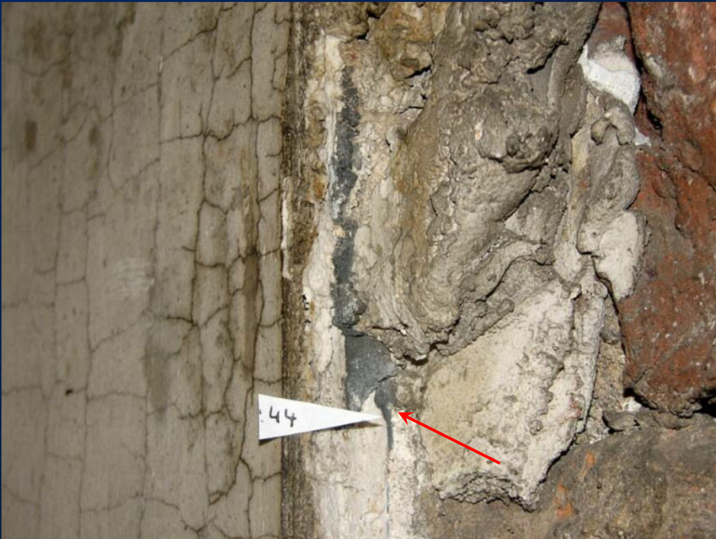
Reste von blauem Stuckmarmor der Pilaster
