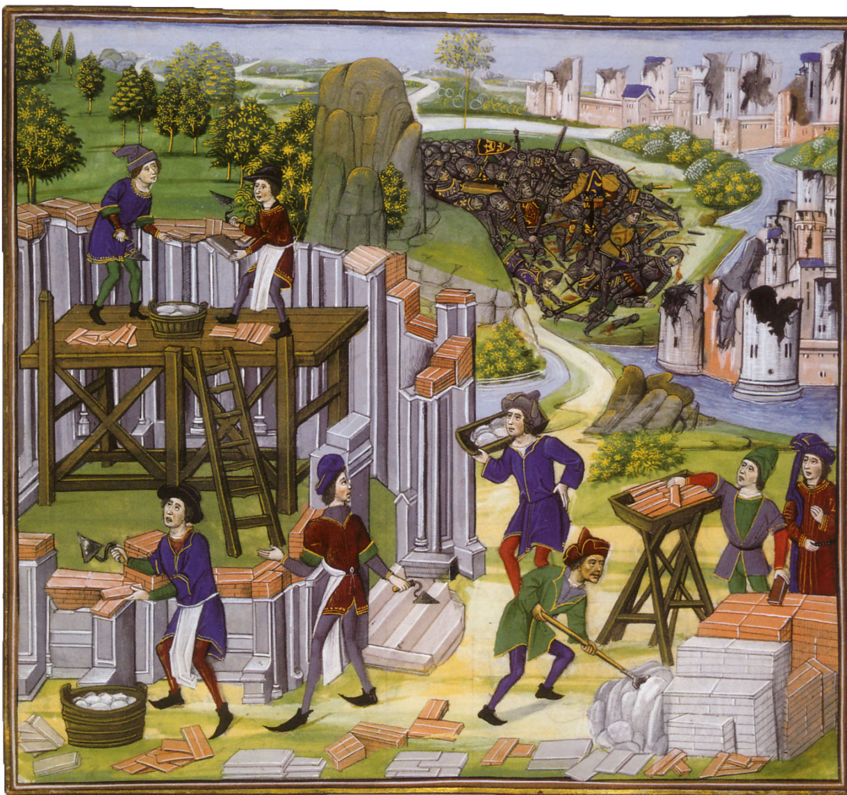
Bau eines gotischen Polygonchores aus verputzten Backsteinen, um 1468: Man sieht Maurer, Mörtelmischer und Träger mit Buck, Leiter und Bockgerüst. Chroniques de Hainaut II., Buchmalerei aus Brügge (Brüssel, Bibl. Royale, Ms. 9243, fol. 168). aus: Binding 2006, S. 89
