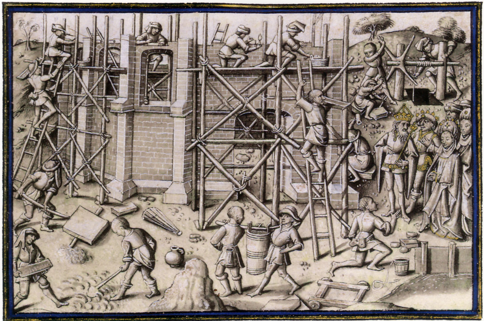
Stangengerüst. J. de Tavernier, Chroniques et Conquêtes de Charlemaïne , um 1450/60 (Brüssel, Bibl. Royale, Ms. 9068, fol. 289). aus: Binding 2006, s. 122
