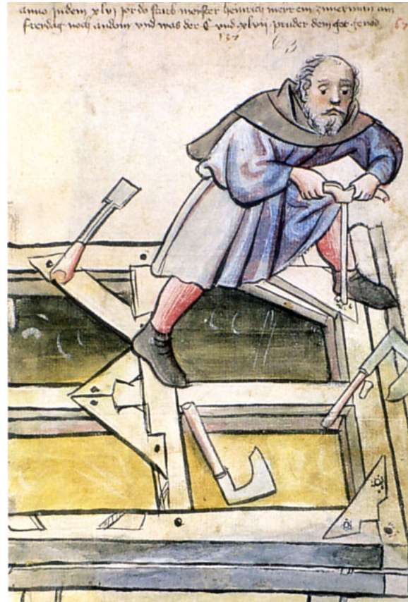
Der Zimmermann (zymerman) bohrt mit einem Löffelbohrer ein Loch für einen Holznagel in das Band einer vorgereiteten Fachwerkwand, auf der zwei Beschlagbeile (Breitbeile) liegen. (fol. 67')
