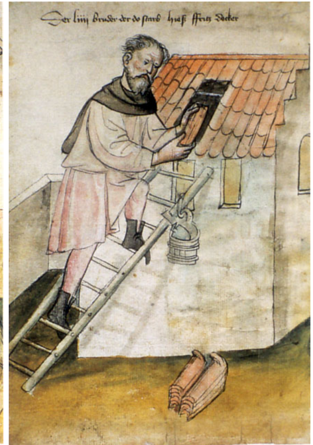
Der Dachdecker (decker) steht auf einer an die Traufseite des Hauses gelehnten Leiter und fügt in der Dachmitte einen Ziegel ein, am Leiterholm Mörtelkübel mit Kelle, am Boden zwei Stapel Hohlziegel. (fol.24v)
