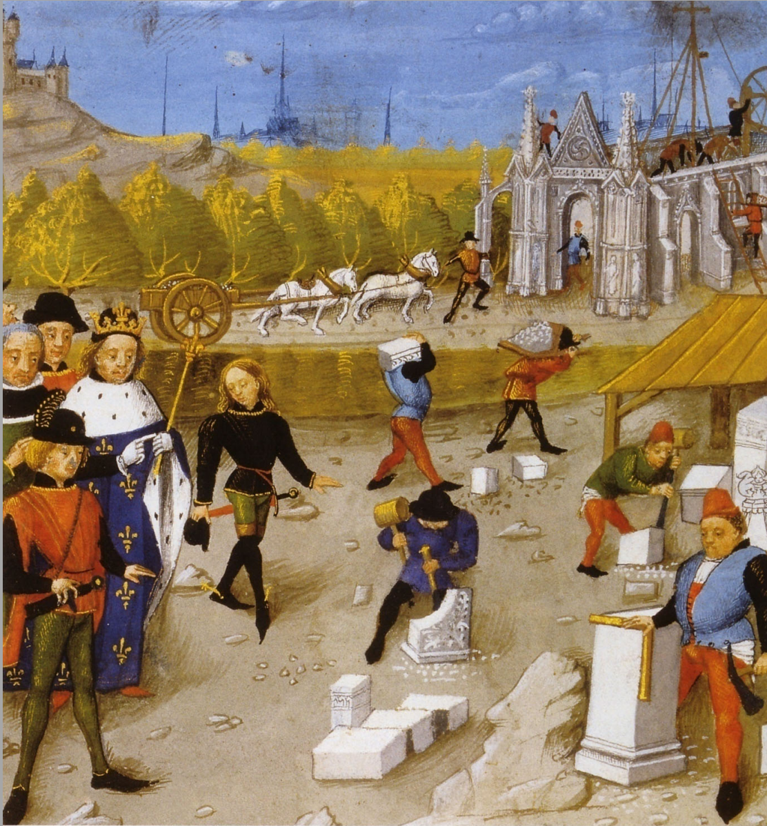
Bau der Kirche von Saint-Denis, Buchmalerei in einer französischen Handschrift. Der König besucht die Baustelle; Steinmetzen, Materialtransport und der Aufbau der Kirche werden gezeigt, 15. Jh. (Paris, Bibl. Nat. ms. fr. 2609, fol. 60 v ). aus: Binding 2006, S. 39
