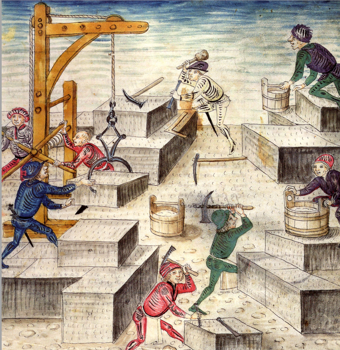
Steinmetzen bei der Arbeit auf dem Werkplatz, Galgenkran mit Haspel und Steinzange; Diepold Schilling, Amtliche Berner Chronik 1478 (Bern, Stadtbibl. Mss. hist. Helv. I, 1, 225). aus: Binding 2006, s. 92
