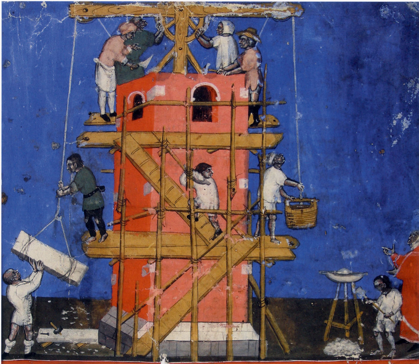
Stangengerüst mit Laufschräge, Rudolf von Ems, Weltchronik, 1385 (Kassel, Landesbibl., Ms. theol. 4, fol. 28). aus: Binding 2006, S. 121
