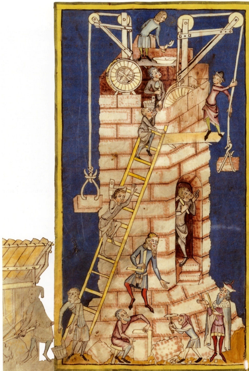
Auslegerkran mit Laufrad, Steinzange und Seilschlaufe. Rudolf von Ems, Weltchronik, 1340/50 (Zürich, Zentralbibl., Cod. Rh. 15, fol. 6v).
