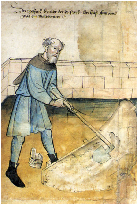
Der Mörtelrührer (morterurer) rührt mit einer Speishau die mit einem Stützbrett gestaute Mörtelmasse, daneben sieht man einen hölzernen Wasserbottich mit Handgriff. (fol.2v).
