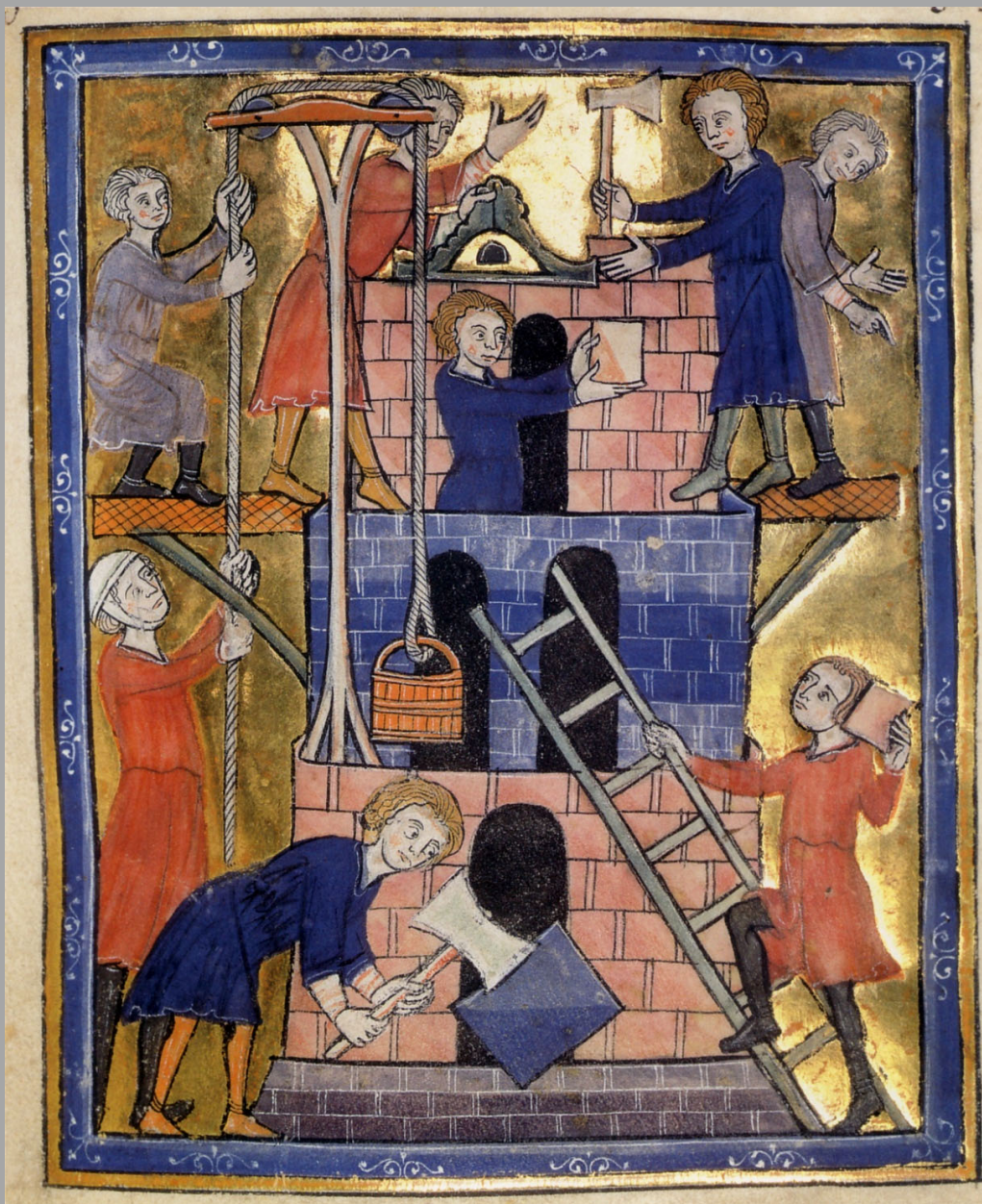
Galgen mit zwei Rollen über die mit der Hand das Seil gezogen wird, Anfang 13. Jh. Französische Bibel (Manchester, John Rylands Library, Ms. fr. 5, fol. 16). aus: Binding 2006, S. 117
