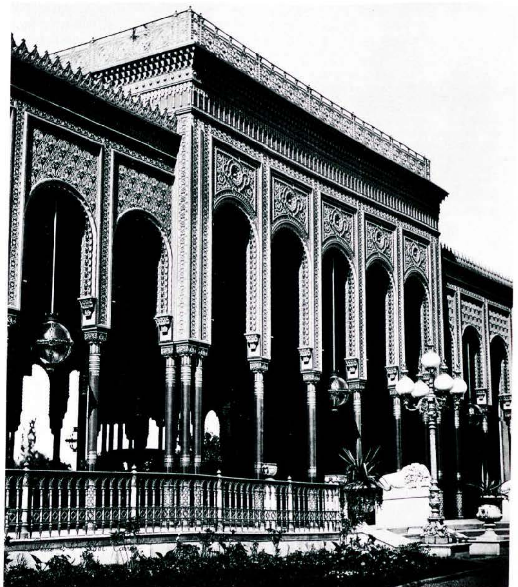
Carl von Diebitsch, »Kiosk« im Garten von Gesira, Kairo, 1865. Historische Aufnahme. Die Kolonnaden und der erhöhte Mittelpavillon bestanden aus vorgefertigten gußeisernen Teilen, die in einer sächsischen Eisengießerei hergestellt worden waren.
