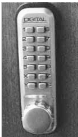
Abb. 3: Das mechanische, code-gesicherte Türschloss des Materialraums
